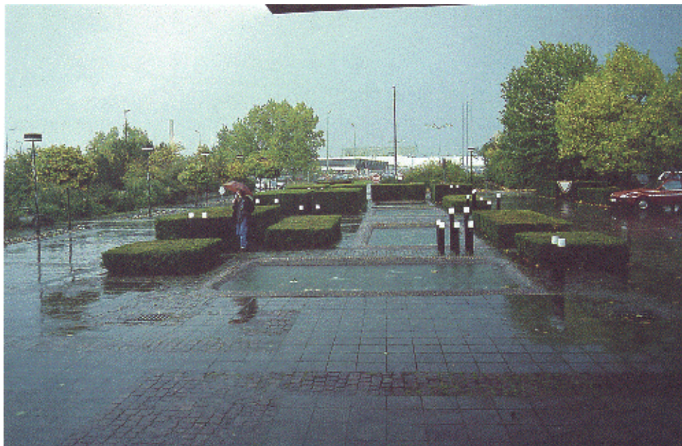
Versickerungsfreundliche Beläge im Innenhof über einer Tiefgarage (Stuttgart)
