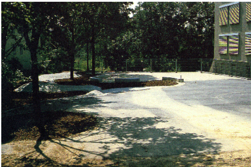
Im Zuge der Umgestaltung wurde mehr als die Hälfte des Asphaltbelags durch wasserdurchlässige Beläge ersetzt
