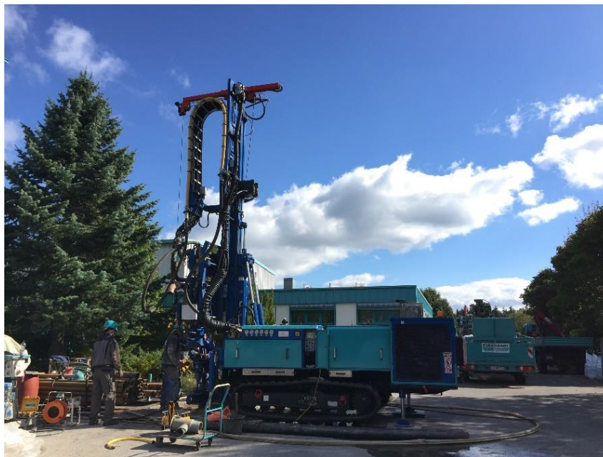
Abb. 158: Ausführung der EWS-Testbohrung.
