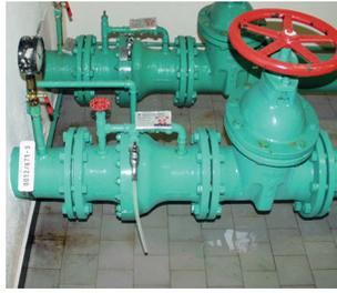
Abbildung 1.2-2: Rohwassermessstelle im Wasserwerk
