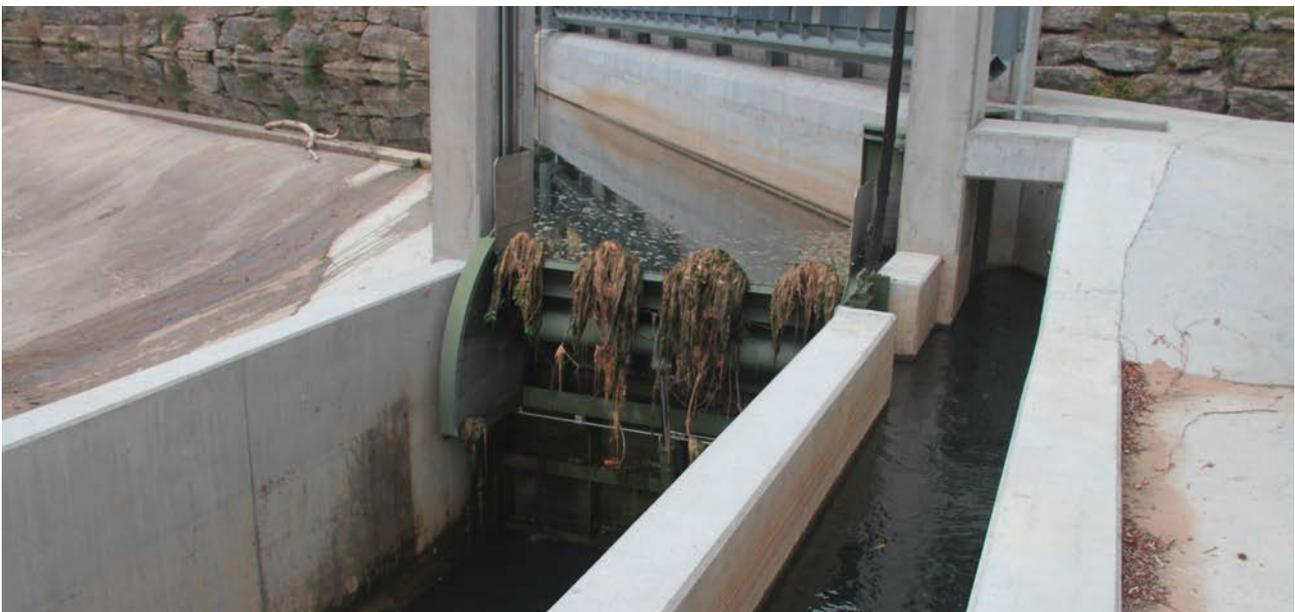
Abb. 4.11: Leitreechen-Bypass-System am Neckar bei Horb
