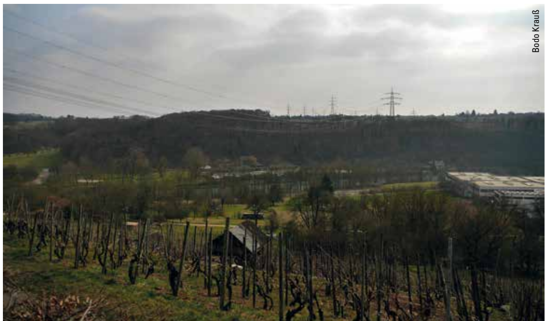
Abbildung 1: Vögel fliegen beim Zug oder bei der Nahrungssuche häufig entlang von Flussläufen. Wo Hochspannungsleitungen solche Flusstäler wie hier am Neckar bei Ludwigsburg und Neckarweihingen quer überspannen, sollten daher wie hier das Erdseil mit entsprechenden Markierungen versehen werden.
