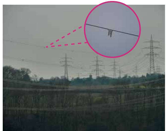
Abbildung 3: Die im Detailbild erkennbaren schwarz-weißen Lamellen markieren das im Vergleich zu den Leiterseilen sehr viel dünnere Erdseil in regelmäßigen Abständen bei der Flusslaufquerung. Durch die Kontrastwirkung, die Bewegungen der Lamellen im Wind und dadurch hervorgerufene Geräusche können Erdseile von Vögeln sogar auch in hellen Nächten wahrgenommen werden. Von Menschen werden sie wegen der vergleichsweise geringen Dimensionen hingegen nicht als störend empfunden. Die Aufnahme stammt ebenfalls vom Neckar bei Neckarweihingen.
