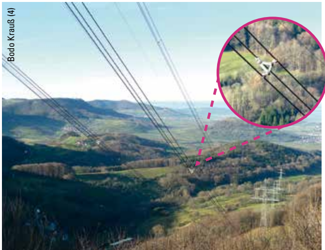
Abbildung 2: Die Leiterseile sind durch ihren Querschnitt, die gebündelte Anordnung und die Verwendung entsprechender Armaturen wie im Detailbild erkennbar für Vögel sowohl am Tage zumindest bei entsprechenden Sichtverhältnissen gut wahrnehmbar. Schwerer zu erkennen ist hingegen das dünne Erdseil.
