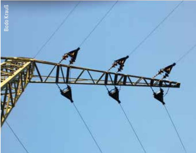
Abbildung 4: Mit der erst kürzlich erfolgten Neuentwicklung von isolierenden Abdeckungen zur Nachrüstung von Armaturen an Doppelabspannmasten und deren Installation an Mittelspannungsleitungen konnte eine erhebliche Todesfalle insbesondere für Großvögel entschärft werden.
