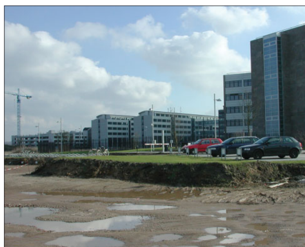
Abb. 16: Neubaumaßnahme in Walldorf, 2002: Gebäudekomplex innerhalb der ca. 1,5 m mächtigen Geländeaufschüttung und den Erschließungsstraßen. Im Vordergrund ist das tiefer liegende Urgelände zu erkennen. Foto: Hagelauer Consult, Walldorf.
