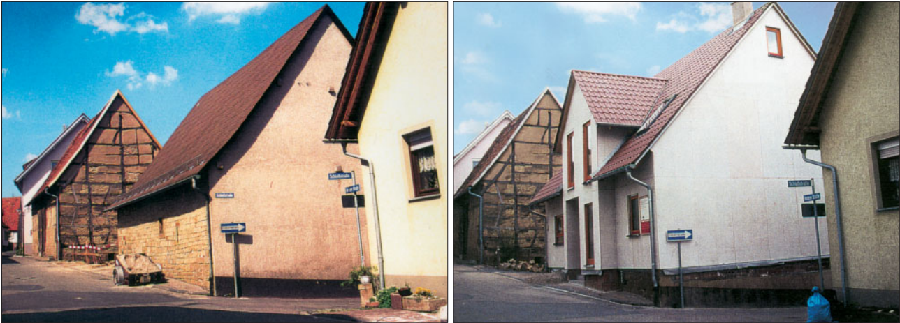
Abb. 10: Umbau einer früheren Scheune zum Einfamilienhaus. Fotos: Gemeinde Sulzfeld.
