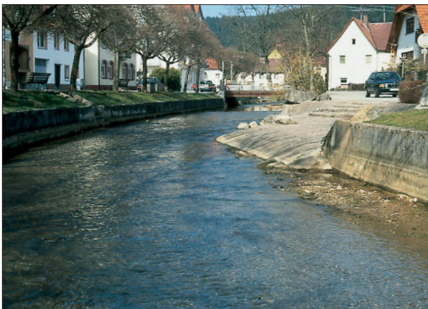
Abb. 24: Der Krähenbach in der Ortsmitte von Tuttlingen-Möhringen, 1997. Foto: Geitz, Stuttgart.
