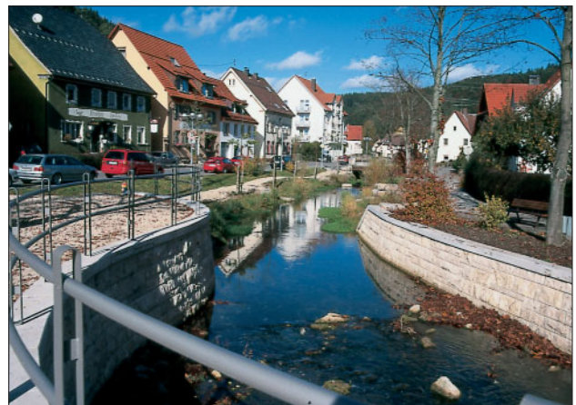
Abb. 25: Der Krähenbach im Jahr 1999, nach Umsetzung der Maßnahme. Foto: Geitz, Stuttgart.
