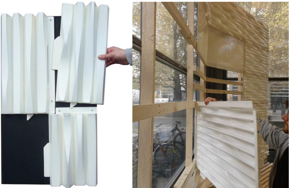
Abb. 31 und Abb. 32 Steckverbinder Trapezwellen-Paneele und Montage ©spek DESIGN
