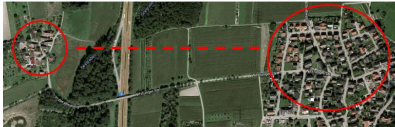
Abb. 4-1: Satellitenbild der Aussiedlerhöfe und schematische Darstellung des Anschlusses an das vorgelagerte Netz
