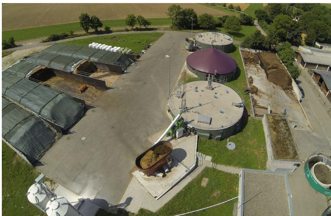
Abbildung 7: Luftansicht der Forschungsbiogasanlage „Unterer Lindenhof“ (Bild: Nägele 2013)
