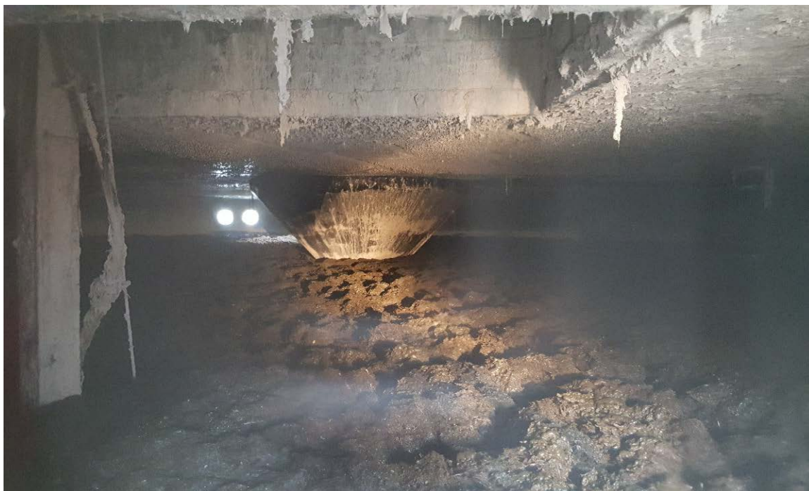
Abbildung 28: Aufnahme der gebildeten Schwimmschichten durch das Bullauge während den Messungen in der zweiten Woche
