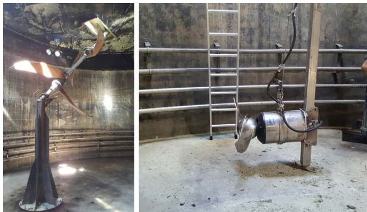
Abbildung 8: Langachsührwerk (links) und Tauchmotorührwerk (rechts) im Fermenter an der Forschungsbiogasanlage „Unterer Lindenhof“
