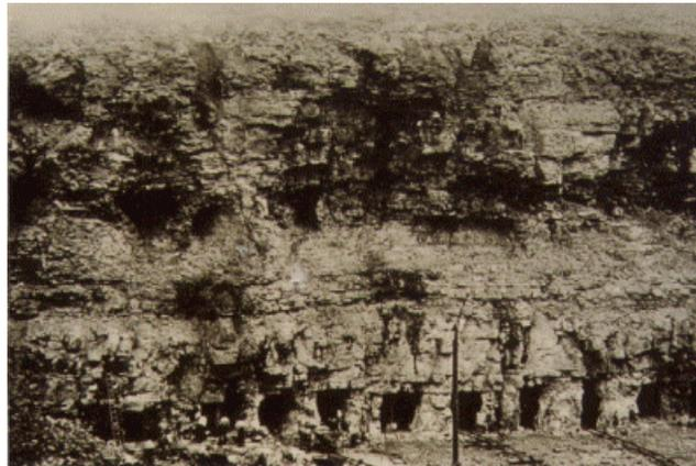
**Abb. 19 : Beim Steinbruchbetrieb angeschnittene Bergbaustollen (obere Bildhälfte); Nußloch um 1910.**
