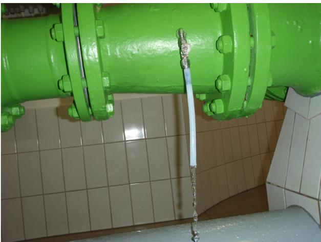
a) Teflonschlauch am Zapfhahn am Verteilernetz
