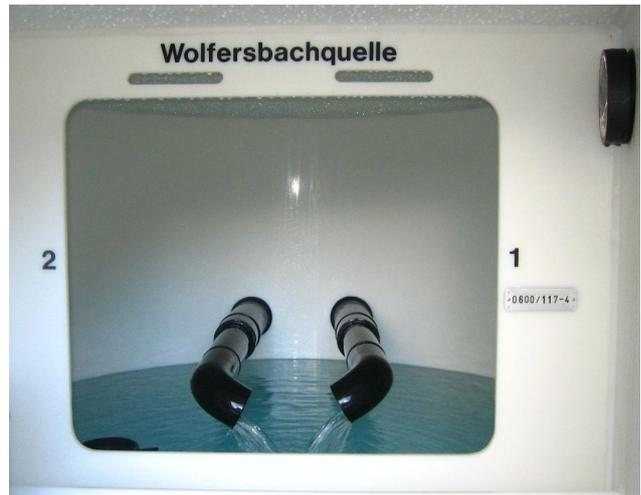
Abbildung 3-9: Zulauf in das Sammelbecken im Quellschacht
