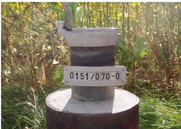
Abbildung 3-1: Messstellenschild der LUBW an einer Grundwasserentnahmestelle
