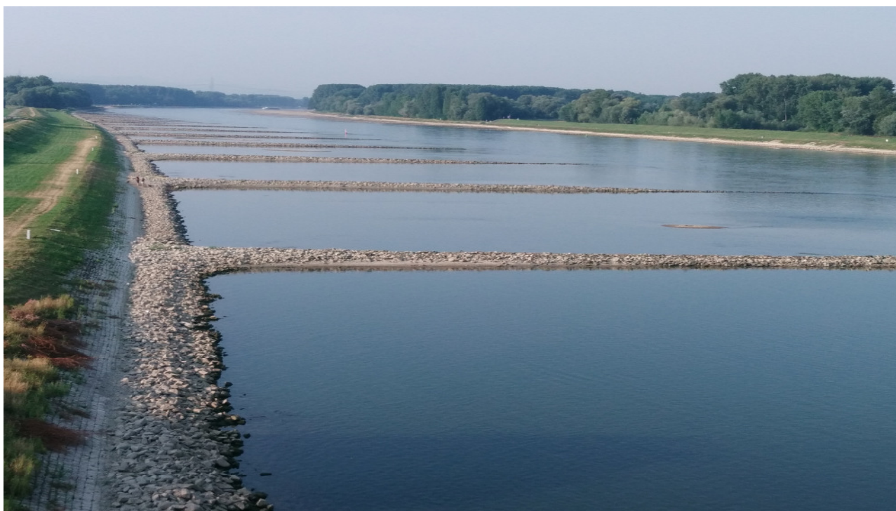
Abb. 10: Niedrigwasser Anfang August 2018 am Rhein bei Karlsruhe (Pegel Maxau). Quelle: S. Plegnière/LUBW
