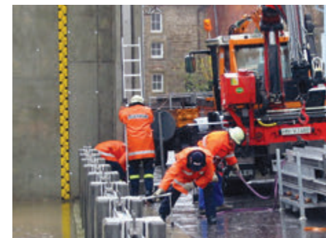
Feuerwehrleute errichten einen Hochwasserschutzwall
