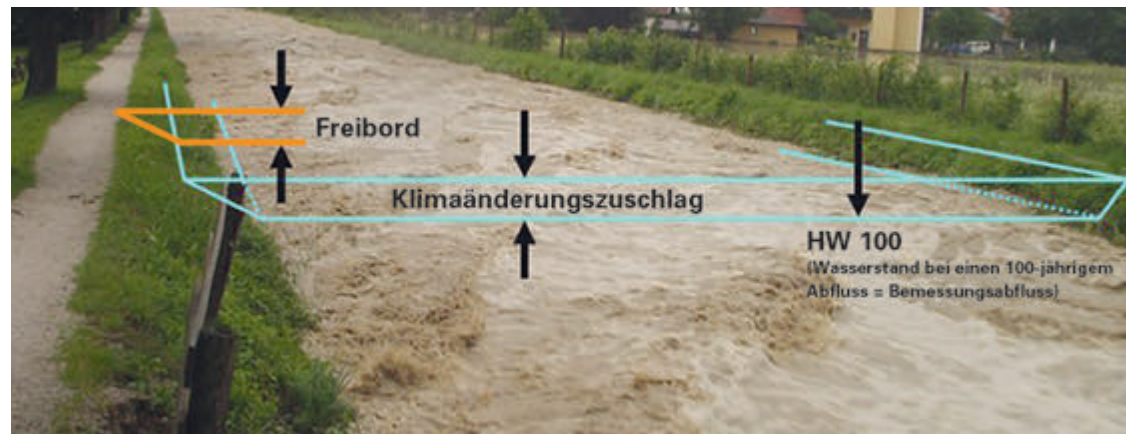
Ein Zuschlag auf den hundertjährigen Hochwasserabfluss bei der Bemessung von Hochwasserschutzanlagen berücksichtigt den möglichen Einfluss des Klimawandels. Der Freibord dient dazu, die Überströmung von Hochwasserschutzanlagen z.B. in Folge von Wellen- und Windstau zu verhindern.
