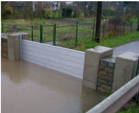
Hochwasserschutz vor einer Einfahrt
