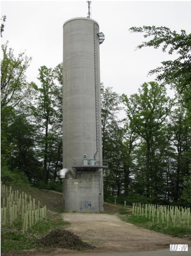
Abbildung 1-2: Abluftkamin auf dem Lindenfirst.
