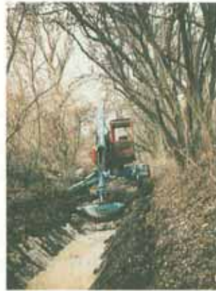
Abb. 65: Innerhalb eines Waldstückes wurde ein Grabenabschnitt mit einem geländegängigen Schreitbagger geräumt.
