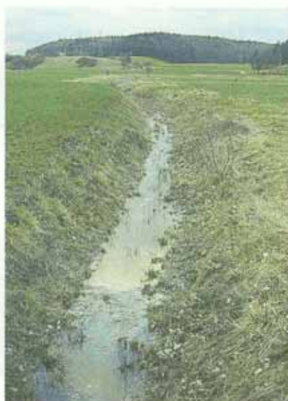
Abb. 26 und Abb. 27: Kleine, kaum spatenbreite Dränagegräben sind vor allem im feuchten Grünland zu finden. Die Hauptvorfluter von Grabensystemen sind Gräben mit z.T. mehreren Meter breiten und tiefen Profilen.
