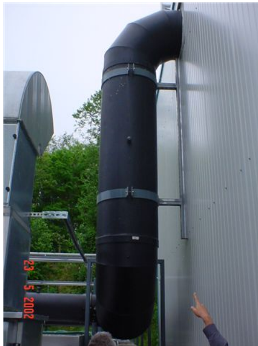
Abbildung 11-2: Ansicht Probennahmestelle Rohgas vor Biofilter
