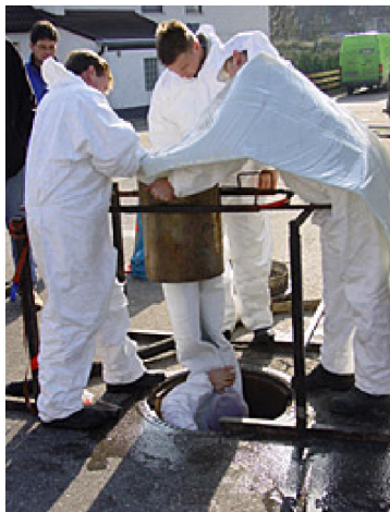
Abb. 5a :Ein mit Harz getränkter Schlauch wird in den Kanal eingebracht
