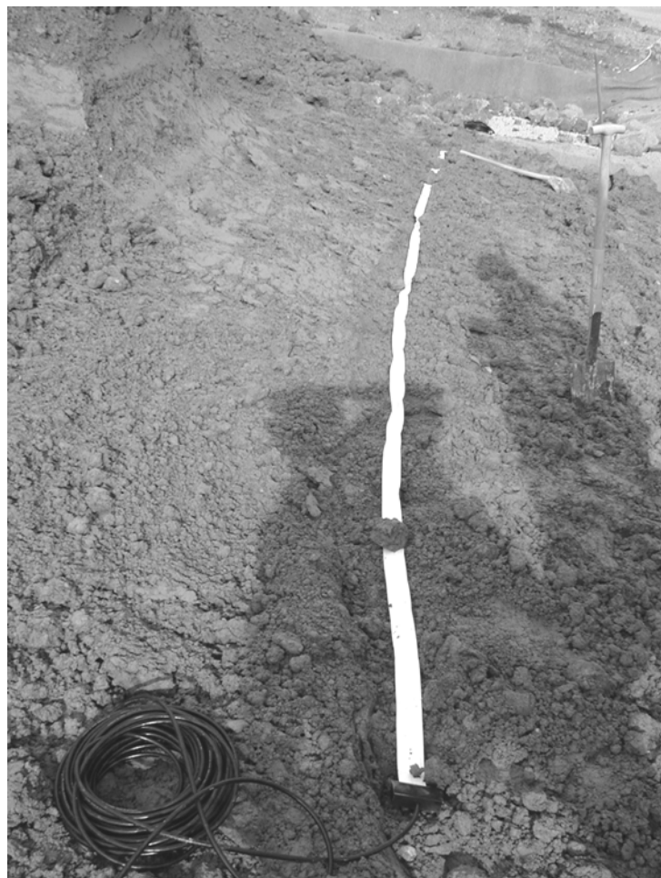
Bild 6: Feuchtemesskabel beim Einbau in der Rekultivierungsschicht
