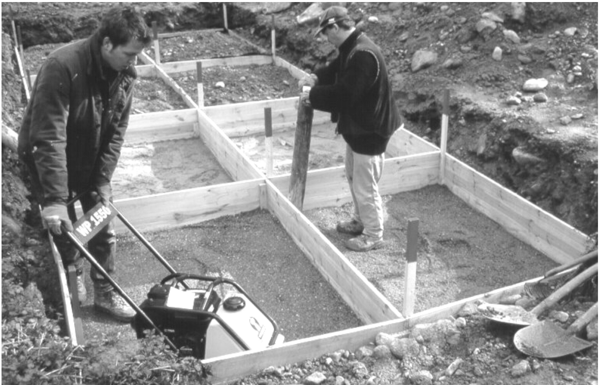
Bild 3: Bau der Wurzelsperren-Testfelder: Einbau und Verdichten des Recycling-Glassplitts
