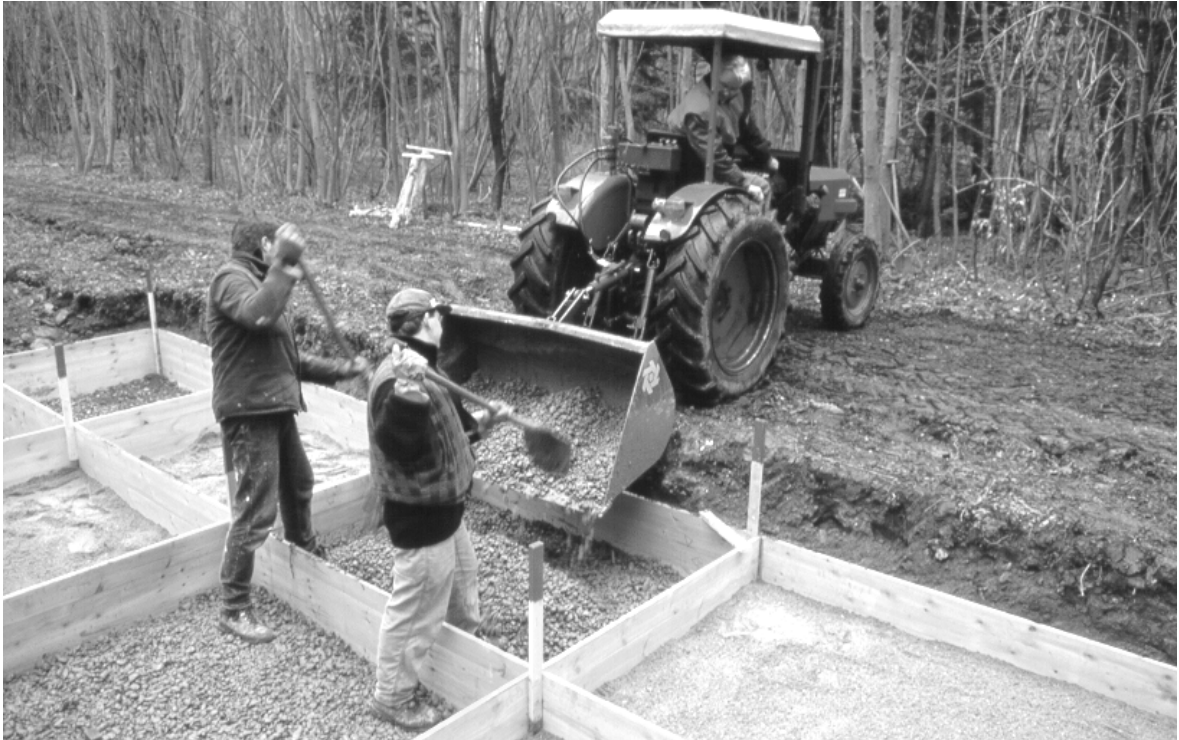
Bild 2: Bau der Wurzelsperren-Testfelder: unverdichtetes Einschütten des Dränbetons
