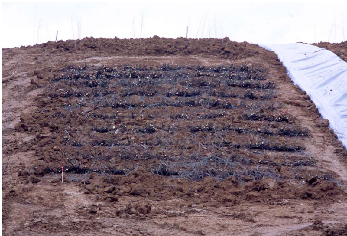
Bild 20: Testfeld mit den eingebauten Buschlagen unmittelbar nach der Fertigstellung im Dezember 2000.
