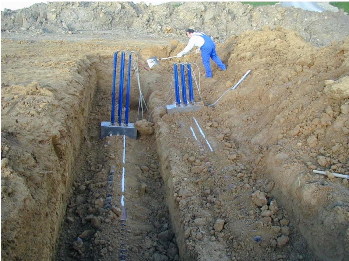
Bild 7: Karlsruher Schertester während des Einbaus in der Rekultivierungsschicht
