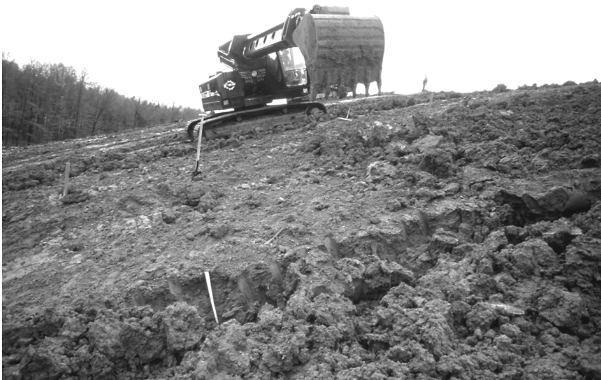
Bild 9: Auflockern des Oberbodens mit dem Teleskopbagger
