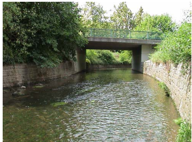
Abb. 28: Saalbach bei Bruchsal mit extremer Uferbefestigung.
