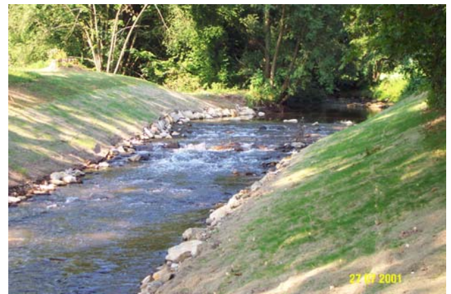
Abb. 51: Umgebaut zur Rauhen Rampe nach wenigen Wochen.
