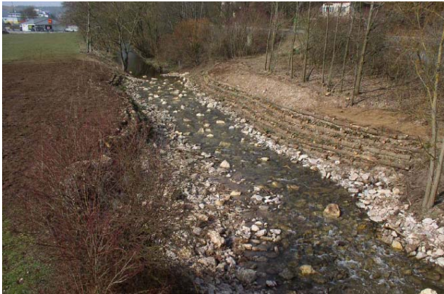
Abb. 53: Raue Rampe ersetzt den Absturz, Holzgrüenschwellen sichern die Böschung.
