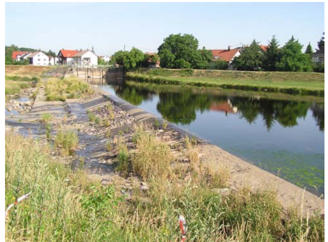
Abb. 25: Streichwehr mit geringem Zufluss zur Ausleitungsstrecke der Murg (WKA in Bad Rotenfels).
