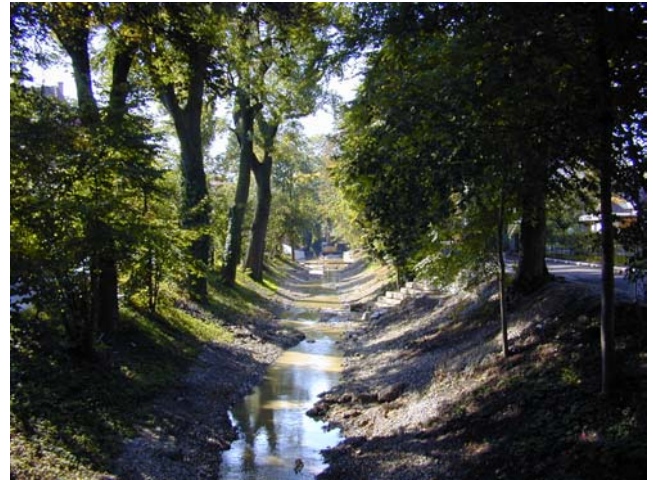
Abb. 42: Ratzengraben nach dem Umbau.
