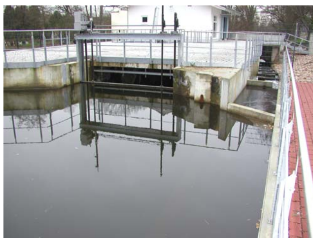
Abb. 60: Einlauf des Becken-Schlitz-Passes.
