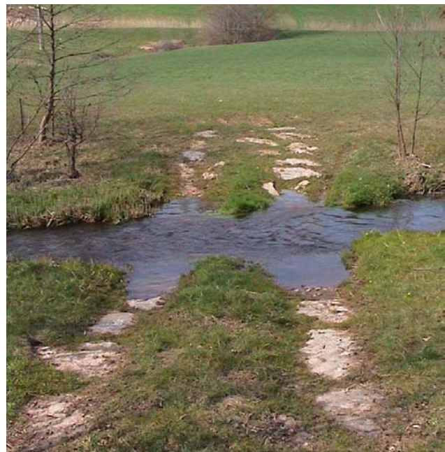
Abb. 64: Eine Furt ersetzt einen Durchlass.
