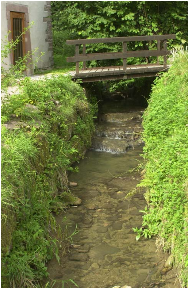
Abb. 30: Tiefenerosion im Mühlenbach bei Dornstetten.
