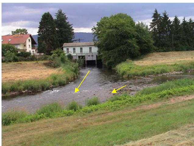
Abb. 24: Umleitungswasserkraftanlage in Bad Rotenfels Triebwerkanal links, rechts Ausleitungsstrecke der Murg.
