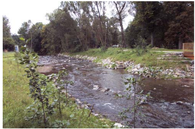
Abb. 55: Raue Rampe und Steinwurf ersetzen den Absturz und den harten Uferverbau.
