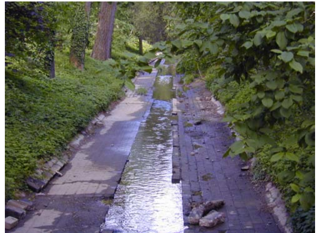
Abb. 41: Ratzengraben hart verbaut.
