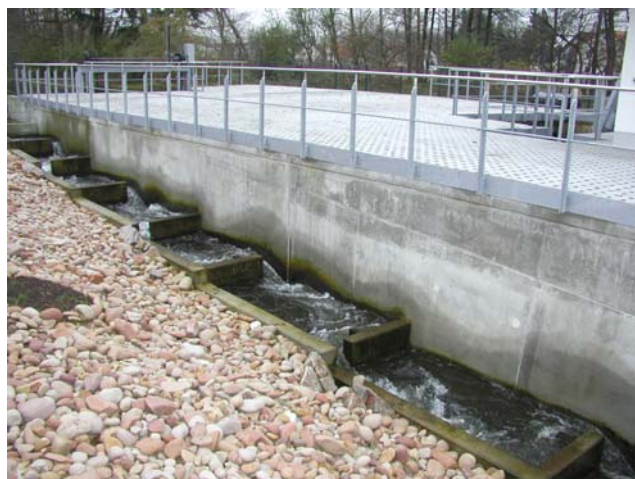
Abb. 59: Becken-Schlitz-Pass am Gewerbekanal in Rastatt-Niederbühl.
