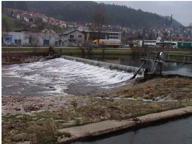
Abb. 18: Regelungsbauwerk einer Wasserkraftanlage an der Kinzig.
