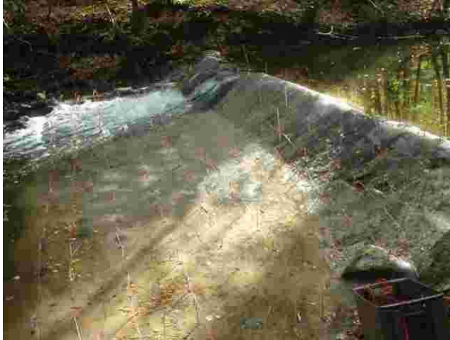
Abb. 38: Absturz vor der Sprengung.
