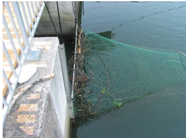
Abb. 67: Reuse am Fischpassausgang.
