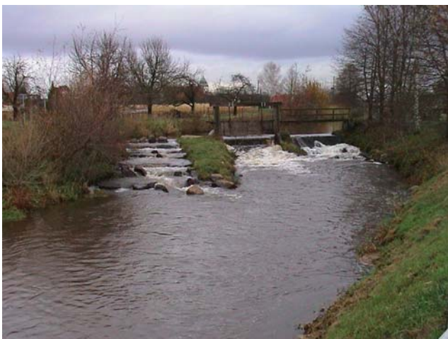
Abb. 49: Ein Raugerinne-Beckenpass umgeht ein Regulierungsbauwerk im Feldbach bei Wagshurst.
