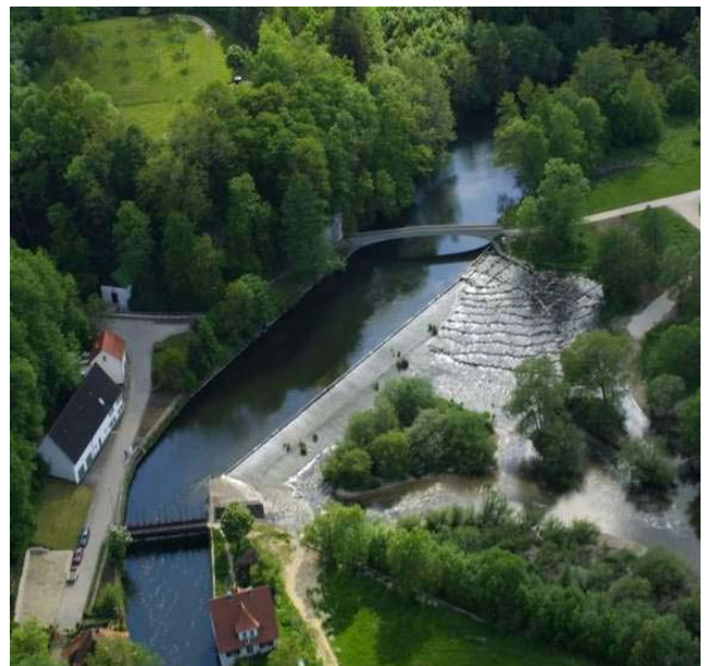
Abb. 57: Teilriegelrampe (rechts) ermöglicht die Durchgängigkeit an der Donau bei der Wasserkraftanlage Alfredstal-Obermarchtal.
