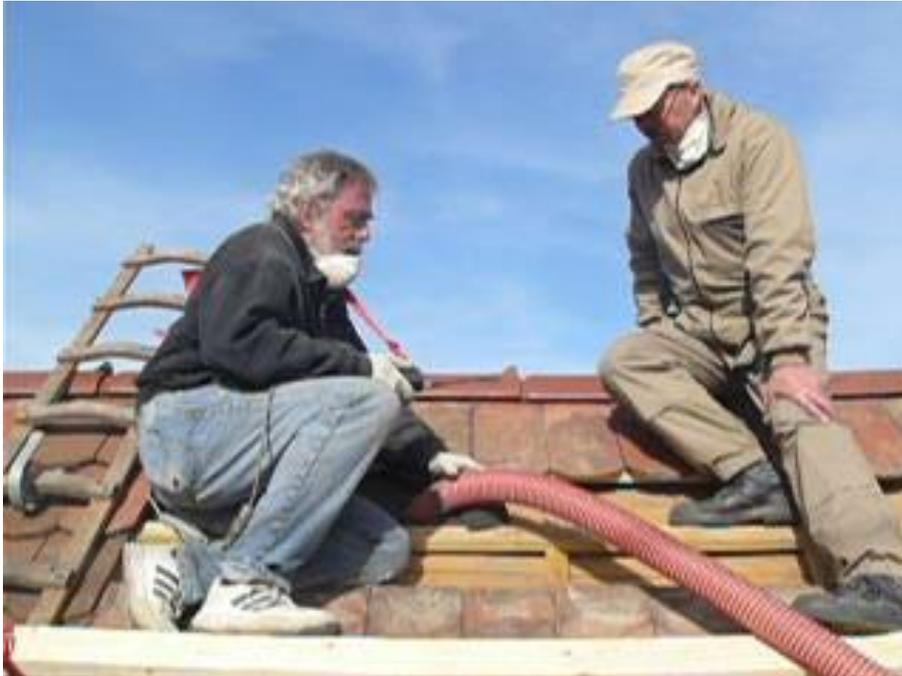
**Abbildung 32: Einblasen des Posidonia-Dämmstoffs von außen unter die Dachhaut**
