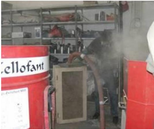
**Abbildung 8: Staubentwicklung beim Einblasen**
