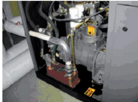
Wärmeauskopplung aus dem Kompressor
