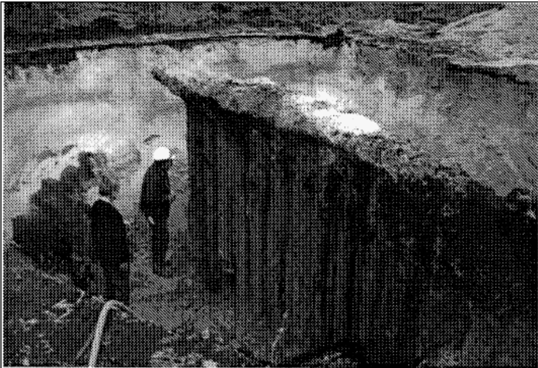
Bild 4.1 Freigelegte Schmalwand (BILFINGER + BERGER 1991)
