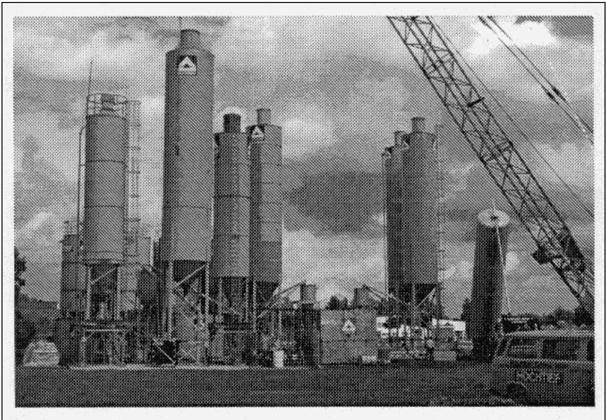
Bild 2.8 Aufbereitungsanlage für eine feststoffreiche Mehrkomponentenmischung
