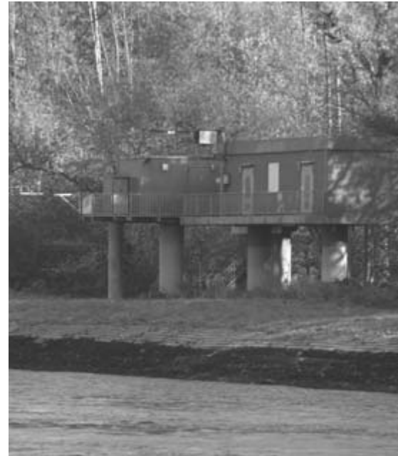
Messstation am Rhein.
