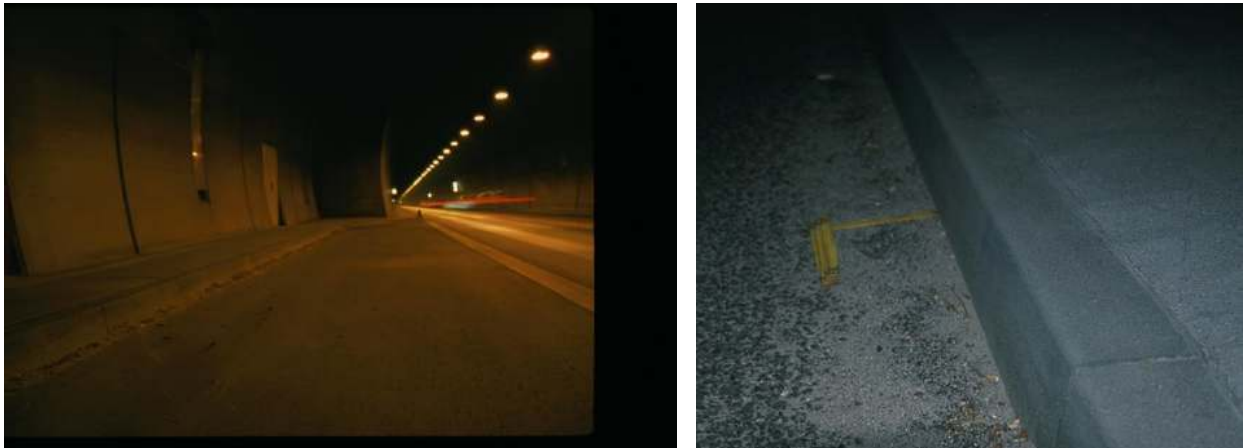
Abb. 4: Beprobung des Grötzingener Straßentunnels, links Probennahmestelle, rechts: Tunnelstaub-Ablagerung
