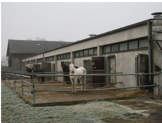
Abbildung 9: Außenansicht Stall P I
