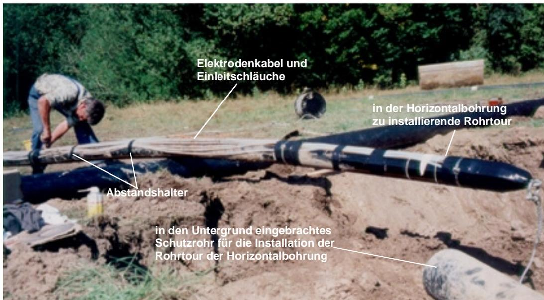
Abbildung 6: Installation von Elektrodensträngen und Einleitschläuchen beim Ausbau der Horizontalbohrung.
