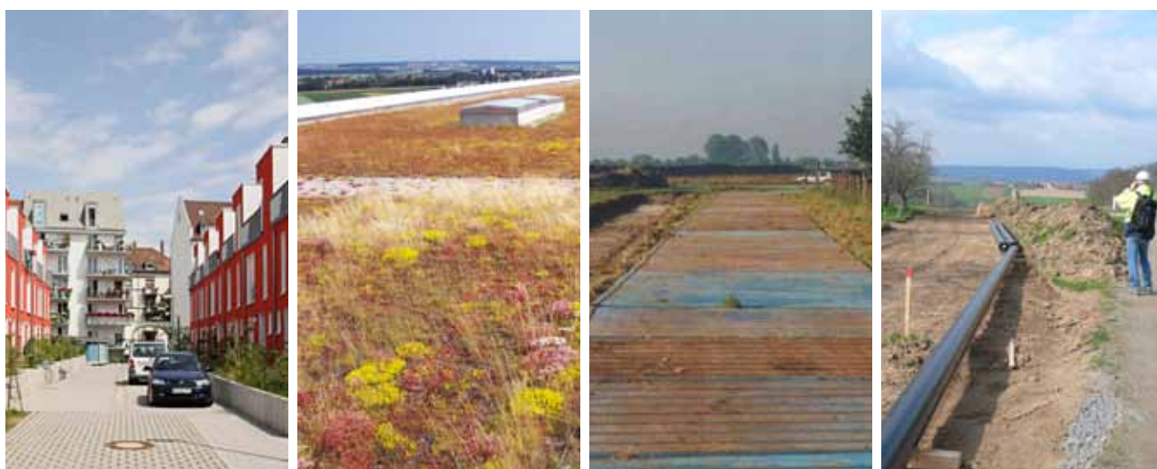
Abb. 4: Vermeidungs- und Minimierungsmaßnahmen beim Schutzgut Boden – Innen- vor Außenentwicklung (links), Dachbegrünung im Plangebiet (Mitte links), Baggermatten als Baupiste (Mitte rechts), bodenkundliche Baubegleitung (rechts)
