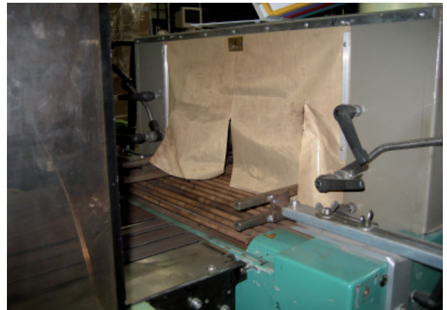
Schrumpftunnel nach Umbau
