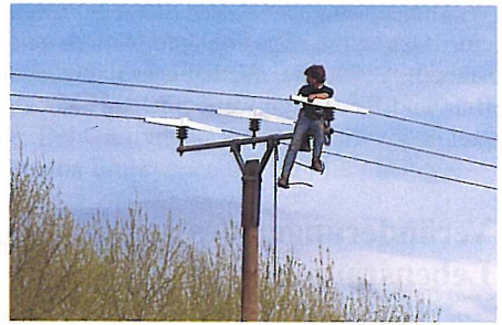
Abb. 10: Zum Schutz vor Stromschlag wird ein Mittelspannungsmast mit isolierenden Kunststoffhauben gesichert. Foto: W. Feld. Hersteller siehe Seite 33.
