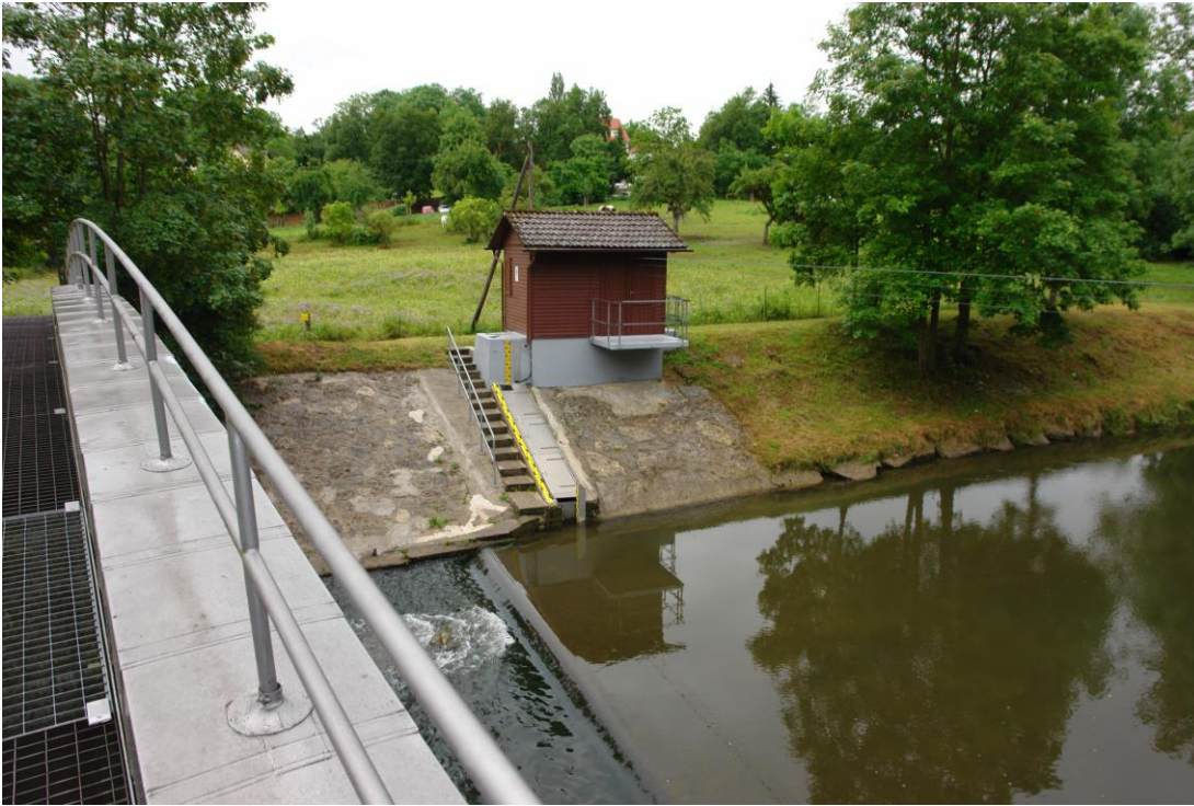
Bild 5: Rottweil-Neckar Pegelhaus, -treppe, Verbindungseinrichtungen 2014-06-30
