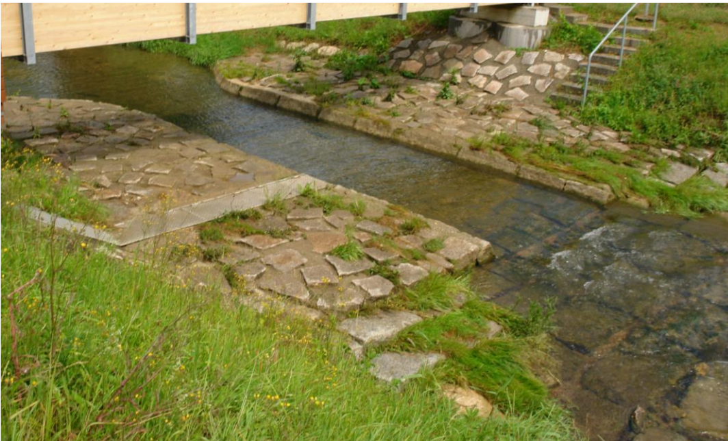
Bild 3: Tuttlingen-Elta Anrampung aus plattigen Steinen als Pegelschwelle bei NW 2014-06-30
