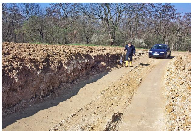
Abb. 3.9-3: weiteres Beispiel für schlechte Auffüllungspraxis. Die Auffüllmächtigkeit ist mit ca. 60 cm zu hoch. Genehmigt waren 20 cm. Das Bodenmaterial wurde beim Einbau stark verdichtet. (Fotos Abb. 3.9-1 bis 3.9-3: Ingenieurbüro Feldwisch)
