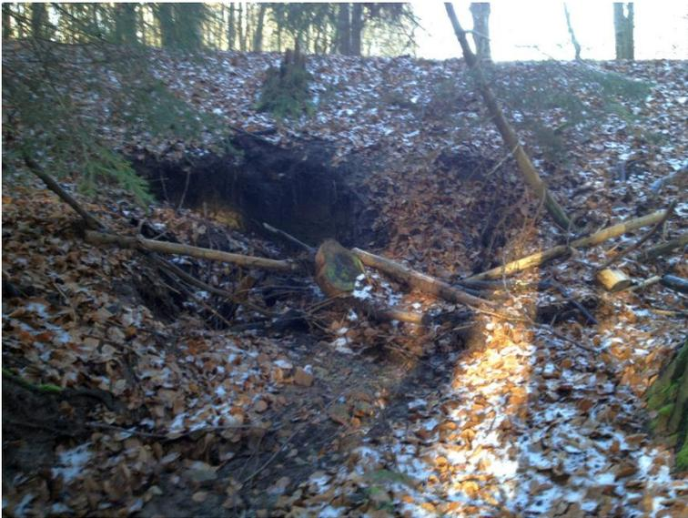
Abbildung 25: Versatz des Durchlasses mit Totholz und Blättern und Rutschung an der Wegböschung
