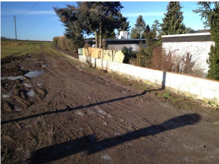
Abbildung 27: Bereich direkt am Rande der Bebauung, deutlich zu erkennen sind deutliche Auffüllungen im Bereich der Wiese, die Bebauung ist etwas durch eine (nachträglich erhöhte) Einfriedung geschützt.
