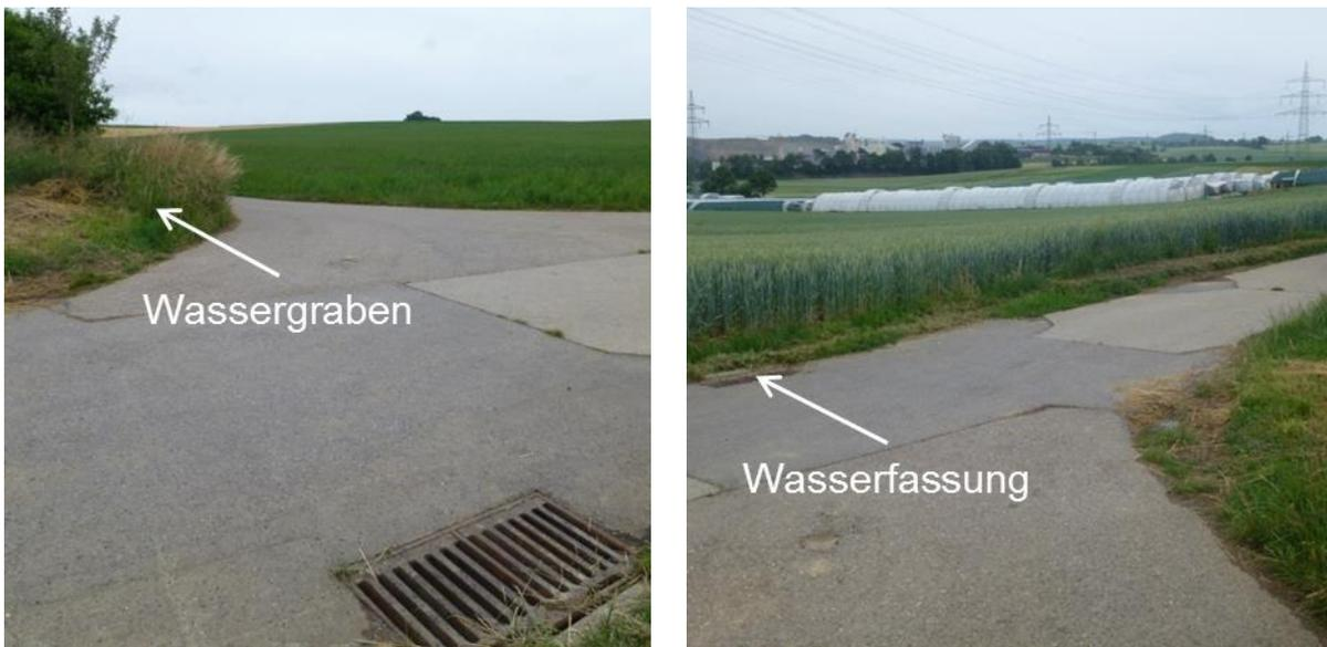
Abbildung 60: Bestehende Wasserfassung durch Verdohlung im Brennpunktbereich „Lange Furche“ in nordwestlicher Richtung (links) und südöstlicher Richtung (rechts)
