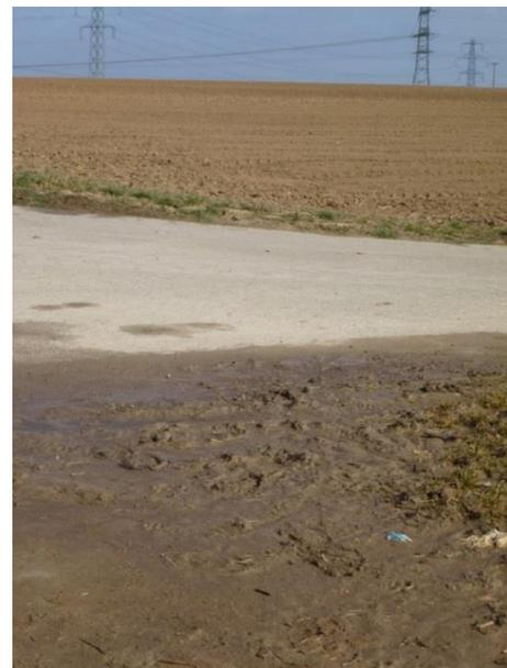
Abbildung 21: Befestigte T-Kreuzung mit Sedimentation des Bodenmaterials aus intensiv bewirtschafteter Fläche im hangabwärtsliegenden T-Bereich
