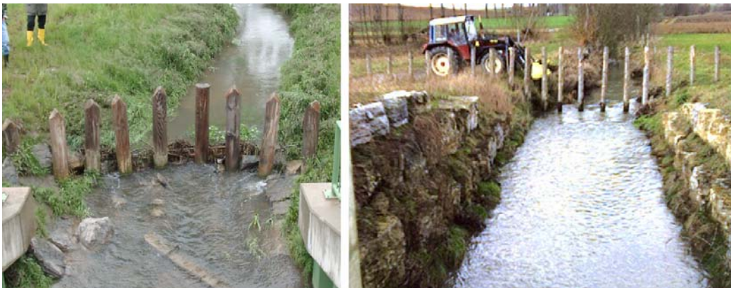
Abbildung 7.9: Verklausung der Pallisaden bei Niedrigwasser (links), Ausräumen per Traktor (rechts) [ZVHWS].
