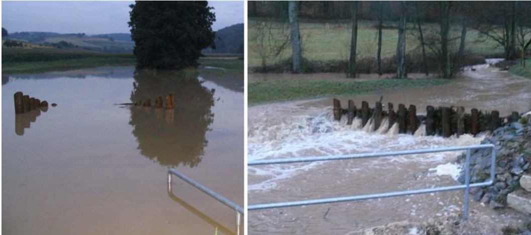
Abbildung 7.8: Pallisaden während eines Hochwasserereignisses, HRB Insenbach (links), HRB Oberschwarzenbach (rechts); [ZVHWS].
