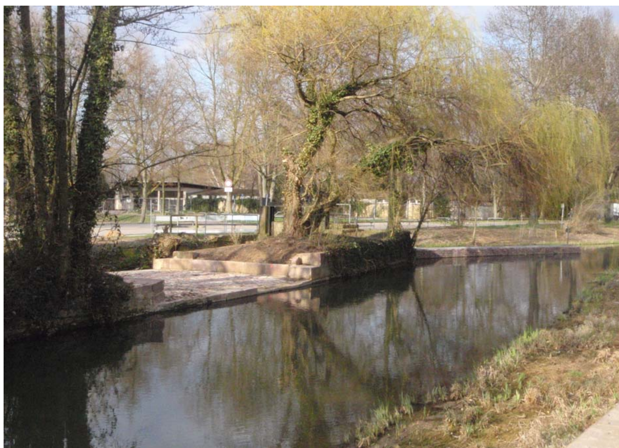
Abbildung A1-4: Ansicht der Insel zwischen Werkkanal und FAA nach Einbau der Scharte zur Hochwasserabfuhr (Stand 30.3.2009)
