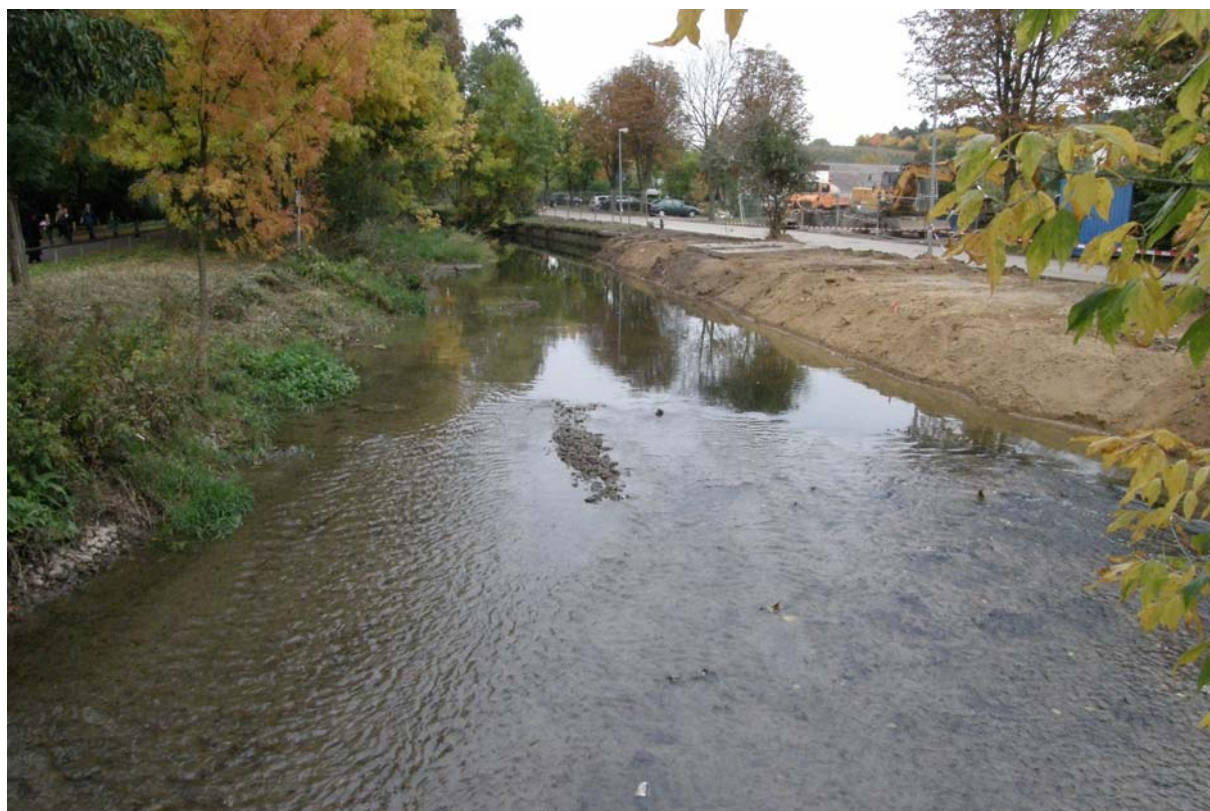
Abbildung A1-5: Blick vom Inselkopf nach Oberstrom (Stand 8.10.2008)
