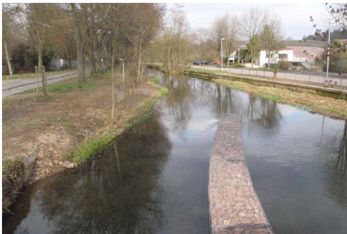
Abbildung A1-6: Blick vom Inselkopf nach Oberstrom (Stand 30.3.2009)
