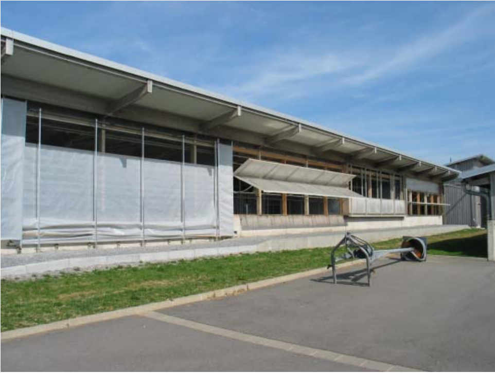
Abbildung 12: Frontöffnung in automatischer Lüftungsstellung (von oben öffnend)
