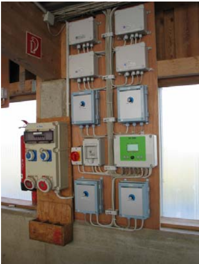
Abbildung 13/14: Schalttafel für Abteilregelsystem, Regel- und Steuergerät im Abteil
