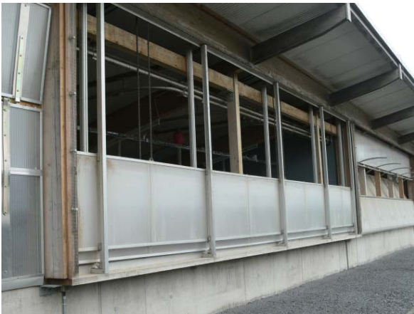
Abbildung 7/8: vertikales Bewegen von 3 Lichtstegplatten mit Kettenantrieb
