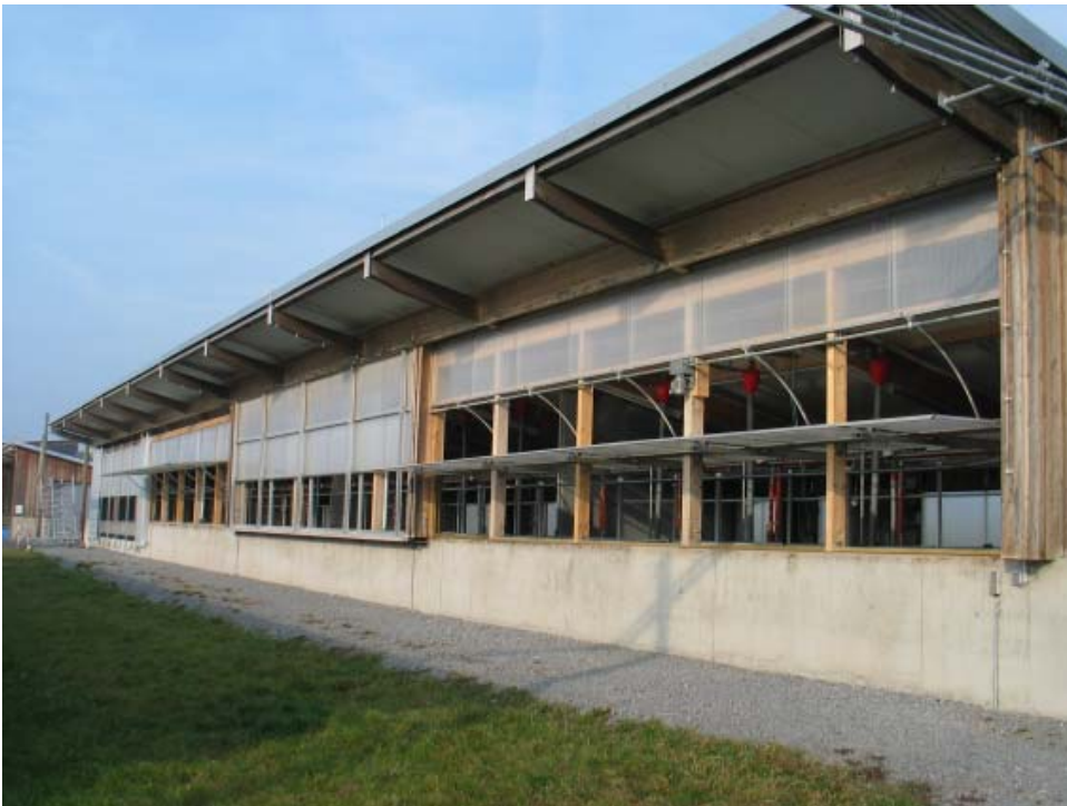
Abbildung 11: Frontöffnungen in Besucherstellung (von unten öffnend)
