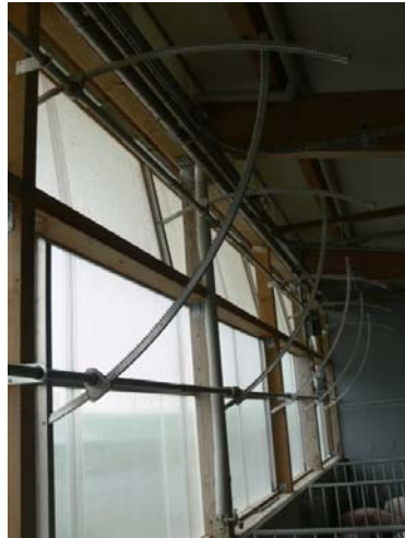
Abbildung 5/6: Kippen von 2 Lichtstegplatten über Zahnstangen oben und unten
