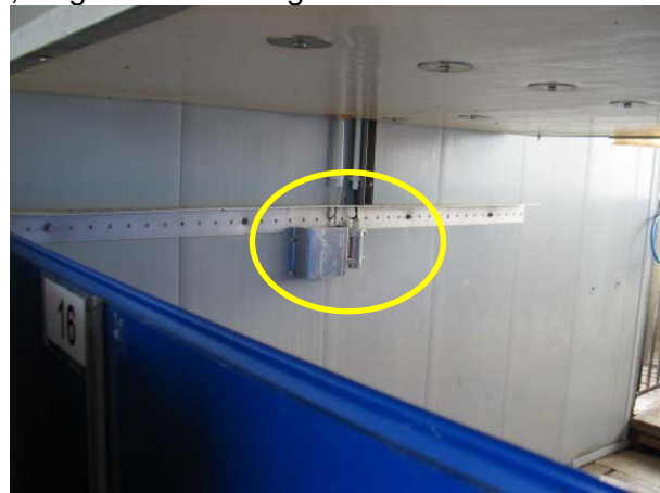
Abbildung 13/14: Schalttafel für Abteilregelsystem, Regel- und Steuergerät im Abteil
