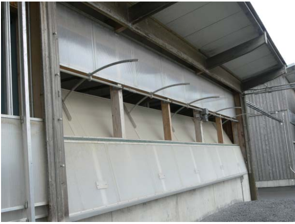
Abbildung 9/10: Kippen einer Lichtstegplatte mittels Zahnstangen (Wendeklappe)
