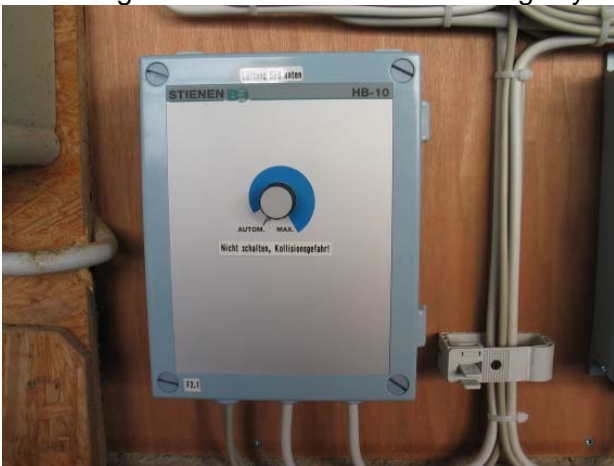
Abbildung 13/14: Schalttafel für Abteilregelsystem, Regel- und Steuergerät im Abteil
