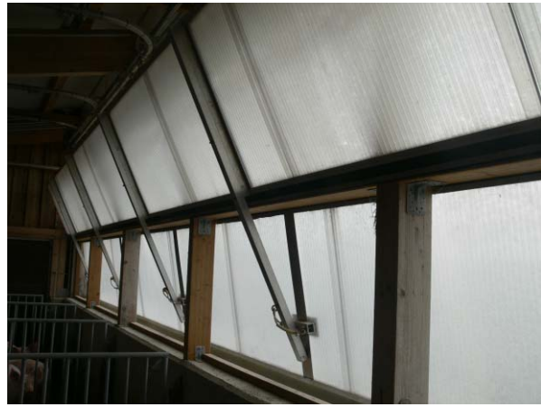
Abbildung 9/10: Kippen einer Lichtstegplatte mittels Zahnstangen (Wendeklappe)
