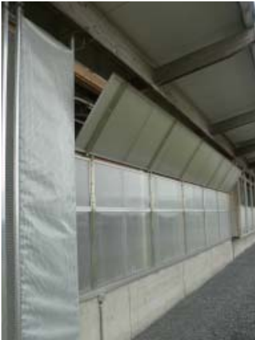
Abbildung 5/6: Kippen von 2 Lichtstegplatten über Zahnstangen oben und unten
