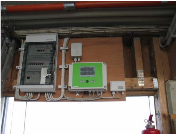
Abbildung 19/20: Zentrales Mastergerät, zentrale Messstelle auf dem Dach für Windgeschwindigkeit und Temperatur
