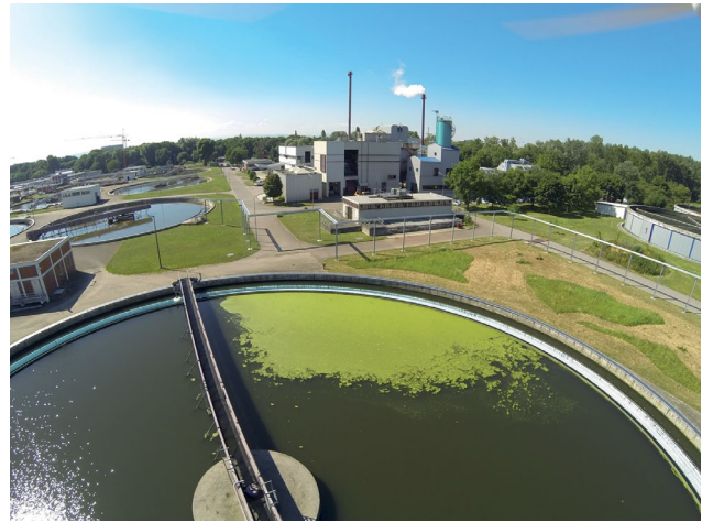
Abbildung 20: Luftaufnahme einer Kläranlage [LUBW]
