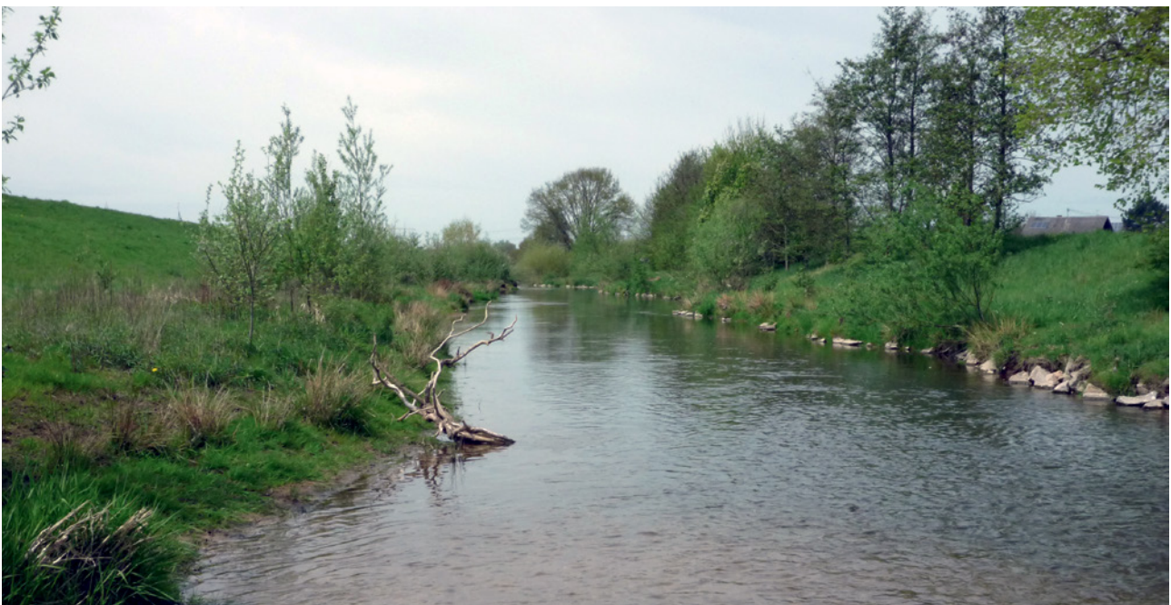
Abb. 5.3: Nach der Maßnahme renaturierter Bachabschnitt mit leicht pendelndem Lauf und mit Gehölzbewuchs an den Ufern
