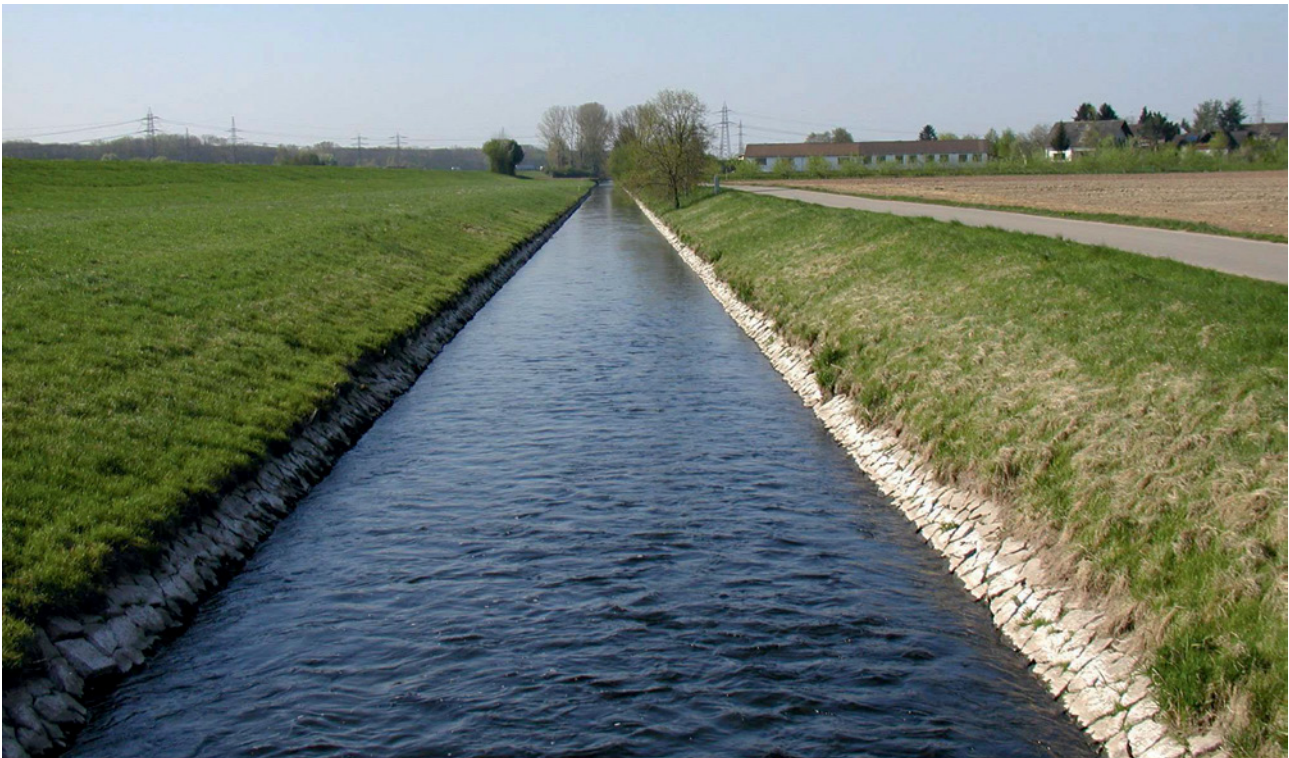
Abb. 5.2: Vor der Maßnahme vollständig begradigter Bachabschnitt mit Regelprofil und Uferbefestigung
