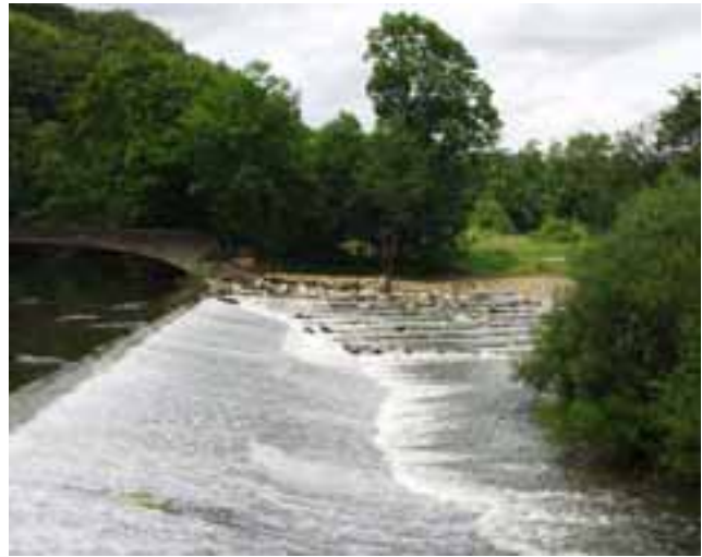
Abbildung D 1: Donau – Obermarchtal. Eine Riegelrampe ersetzt einen Teil des Streichwehrs und dient als Durchgängigkeits- und Dotationsbauwerk
