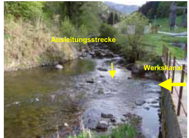
Abbildung B 11: konkurrierende Strömung aus dem Werkskanal
