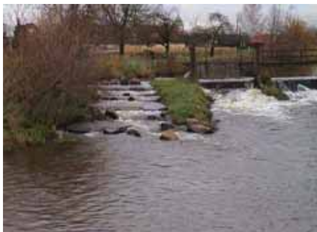
Abbildung D 3: Teilrampe als Durchgängigkeits- und Dotationsbauwerk
