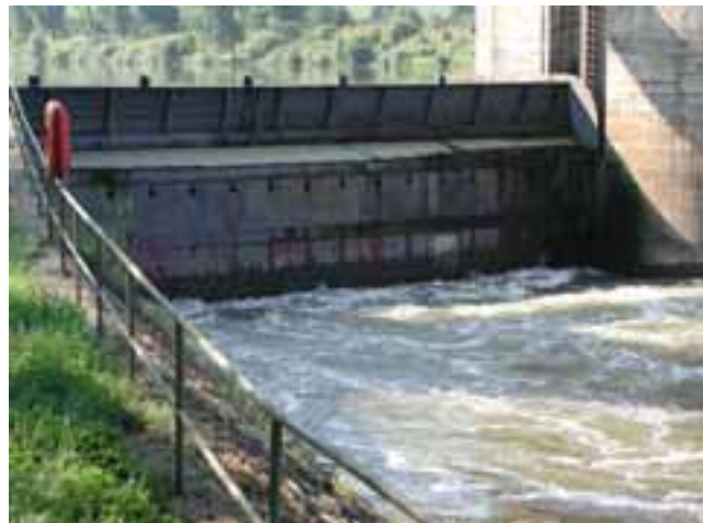
Abbildung C 3: Unterströmtes Schütz (Dotationsversuch Horkheim)
