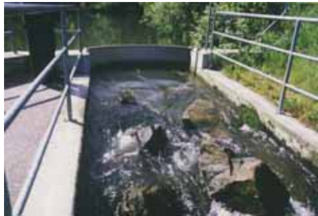
Abbildung C 7: Feste unterströmte Blende zur Dotation und Verhinderung von Treibguteintrag in die Rampe
