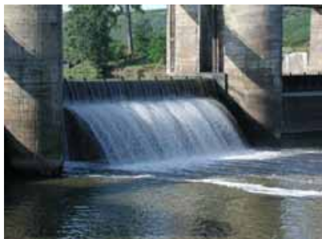
Abbildung C 5: Überströmtes Schütz (Dotationsversuch Horkheim)
