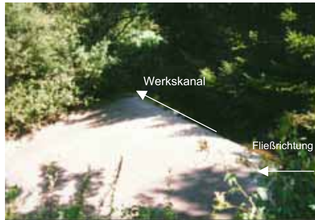
Abbildung 4.5: Wehr an der Ausleitungsstrecke der Stunzach
