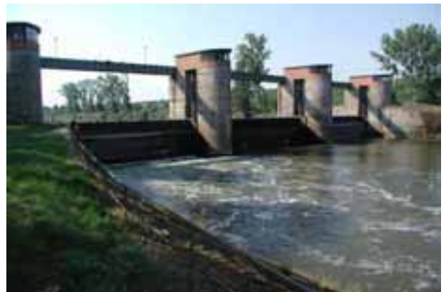
Abbildung 9.15: Durchflusssteuerung in der Ausleitungsstrecke durch das Ausleitungswehr. Oben links: Q = 1,2 \text{ m}^3/\text{s} (23.07.01); oben rechts: Q = 1,7 \text{ m}^3/\text{s} (24.07.01); unten links: Q = 2,5 \text{ m}^3/\text{s} (27.07.01); unten rechts: Q = 30,9 \text{ m}^3/\text{s} (25.07.01).
