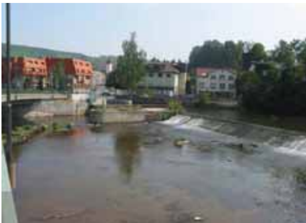
Abbildung 10.3: „Ausleitungsstrecke“ der WKA Niefern zwischen Brücke und Wehr bei einem Abfluss von 1,2 m 3 /s (Sommer 2003).
