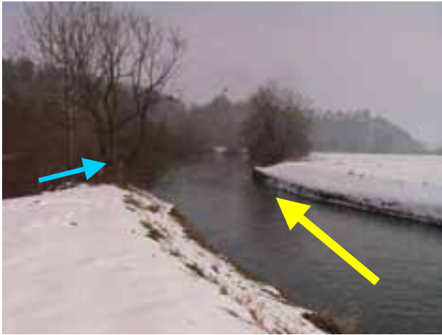
Abbildung C 13: Hauptströmung aus dem Unterwasserkanal (gelber Pfeil), geringe Strömung aus der Ausleitungsstrecke (blauer Pfeil)
