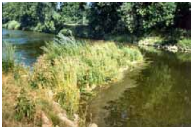
Abbildung D 4: Donau – Öpfingen, eine Buhne bündelt die Leitströmung
