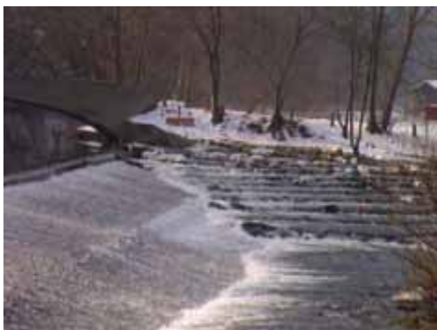
Abbildung 5.6: Wehrüberlauf am Streichwehr, Wehrklappe und Raue Teilrampe.
