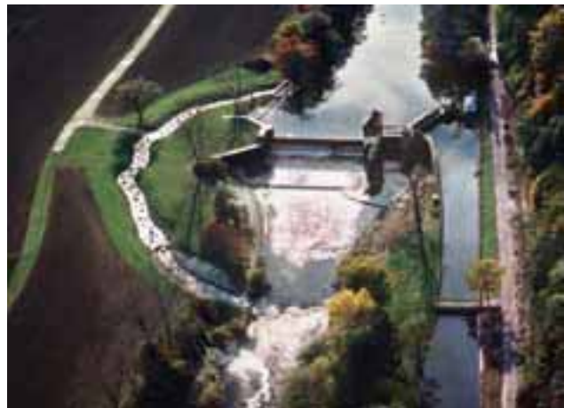
Abbildung C 1: Neckar und Verbindungsgewässer bei Kirchentellinsfurt
