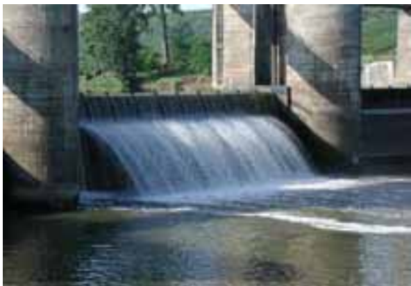
Abbildung 9.15: Durchflusssteuerung in der Ausleitungsstrecke durch das Ausleitungswehr. Oben links: Q = 1,2 \text{ m}^3/\text{s} (23.07.01); oben rechts: Q = 1,7 \text{ m}^3/\text{s} (24.07.01); unten links: Q = 2,5 \text{ m}^3/\text{s} (27.07.01); unten rechts: Q = 30,9 \text{ m}^3/\text{s} (25.07.01).
