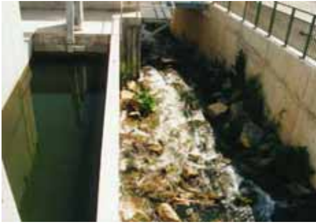
Abbildung 1.5: Fischaufstiegsanlage am Ausleitungswehr WKA Rappenberghalde
