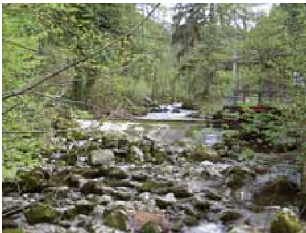
Abbildung 7.5: Ausleitungswehr des Wasserkraftwerkes bei einem Abfluss von ca. 60 l/s (1/6 MNQ)
