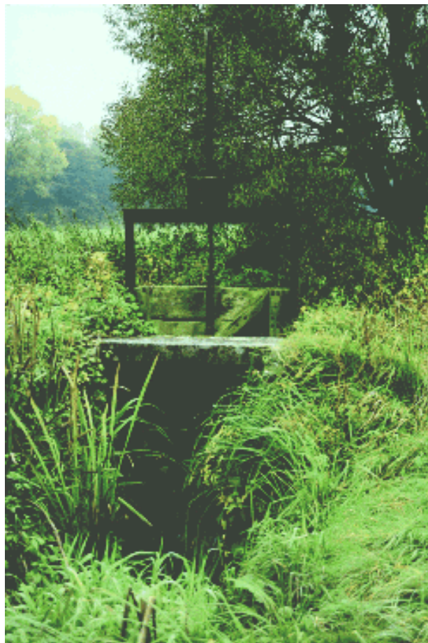
Abb. 13: Wehr in einem ehemaligen Hauptbewässerungsgraben in den Oberbruchwiesen bei Graben-Neudorf
