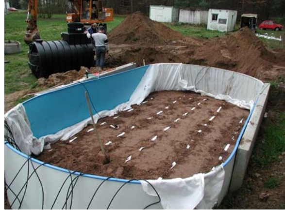
Bild 3: Lage der Sensoren im dritten Horizont
