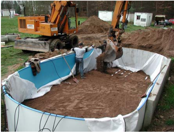
Bild 2: Einbau des Lysimetermaterials
