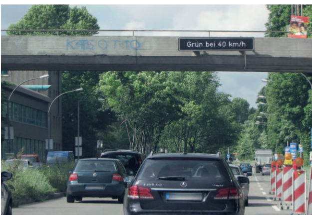
Bild 1: Anzeigetafel für die flexible Geschwindigkeitsempfehlung am Heinrich-Baumann-Steg
