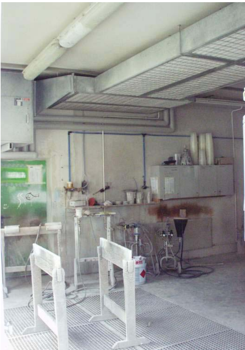
Abb. 3.1.1: Lackiererraum der untersuchten Schreinerei
