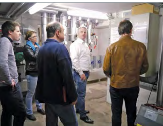
Besichtigung des Heizungsverteilers der „Neuen Mitte Asperg“
