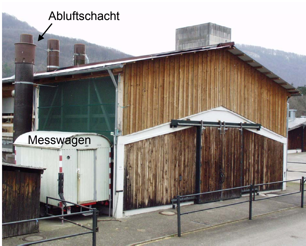
Bild 7: Außenansicht des Mastschweinestalls
