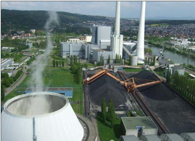
Abbildung 11: Kohlekraftwerk Altbach-Deizisau mit Hybridkühlturm (Foto: Johst 2013)
