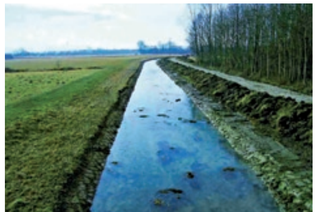
Abb. 8.1: Räumung von Auflandungen am Neugraben
