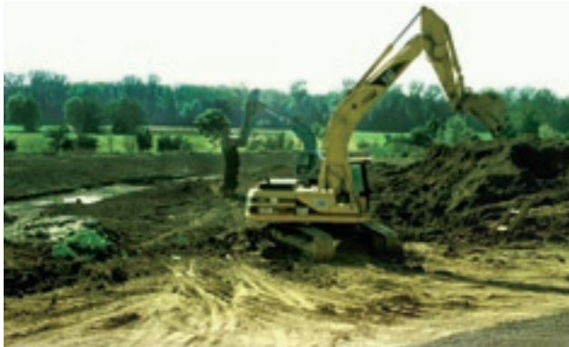
Abb. 8.7: Der Holchenbach während der Bauphase (Foto: R. Jehle)
