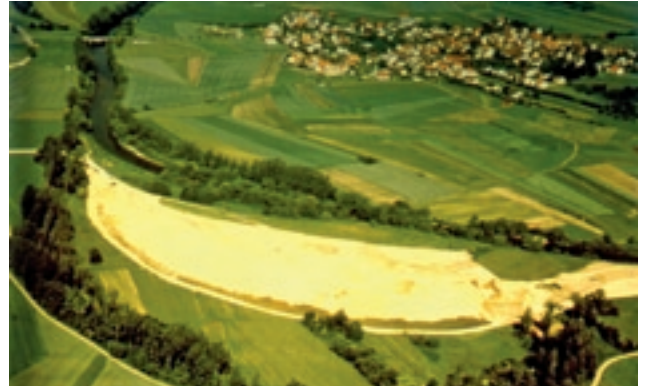
Abb. 8.15: Baustelle am Blochinger Sandwinkel im Juni 1992
