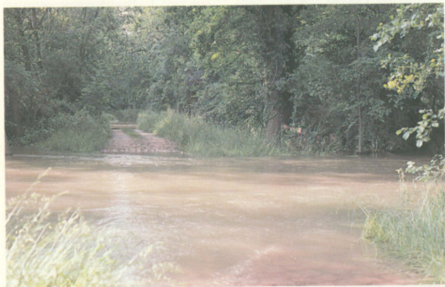
In Feuchtwäldern wird der Waldwegebau dem natürlichen Geländeverlauf angeglichen. Hierdurch werden Feuchtgebiete nicht durchschnitten und der Hochwasserabfluß so wenig als möglich behindert. Hier ein abgesenkter Wegeabschnitt in der Rheinaue, der bei Hochwasser überflutet wird.
