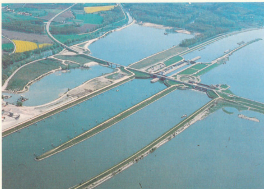
Die Staufstufe Iffezheim wurde 1977 fertiggestellt. Unterhalb dieser Staufstufe sind noch intakte Auwälder vorhanden.
