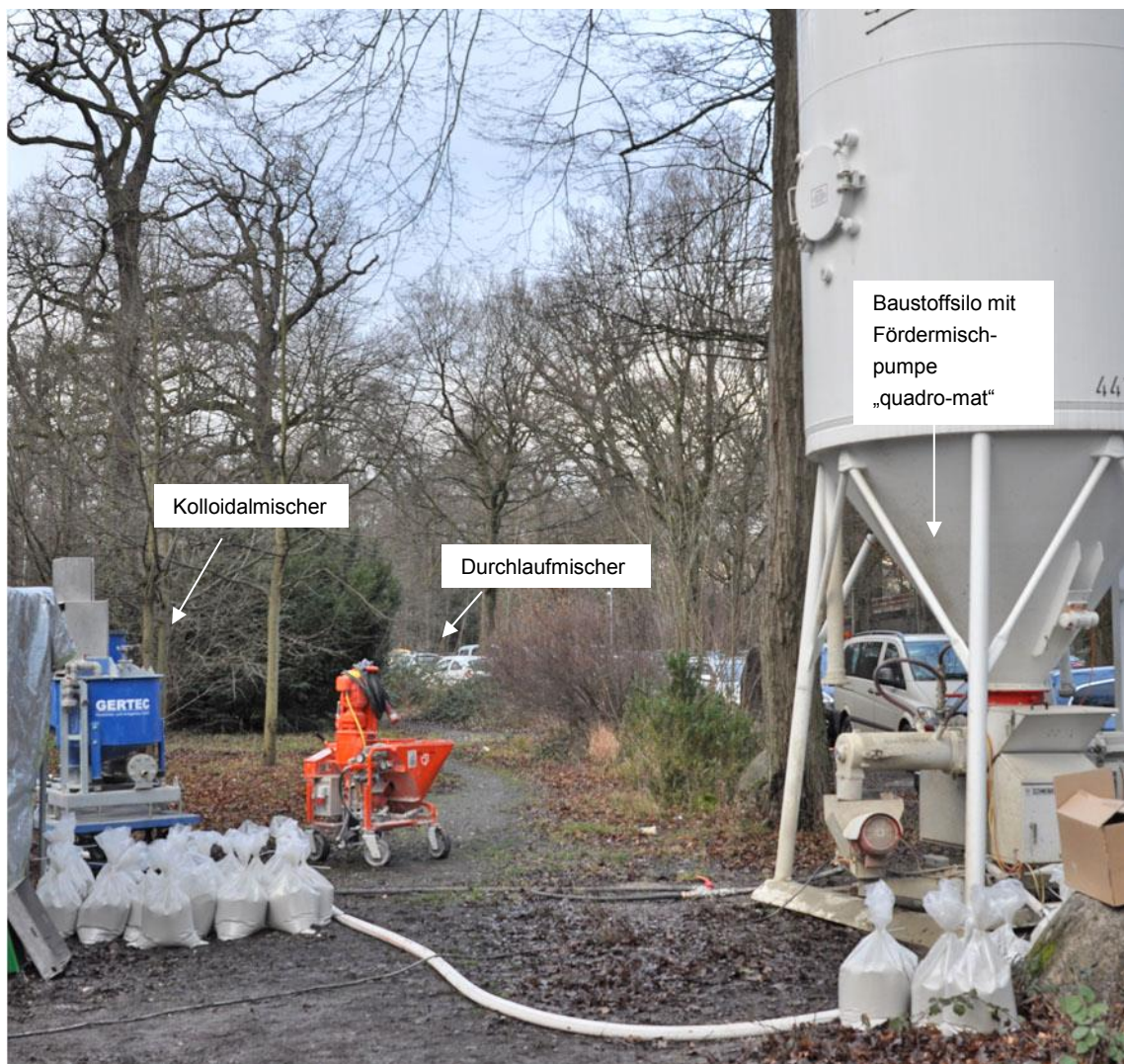
Abbildung 5-3: Übersicht der bei den Realmaßstabsversuchen verwendeten Misch- und Verfüllanlagen
