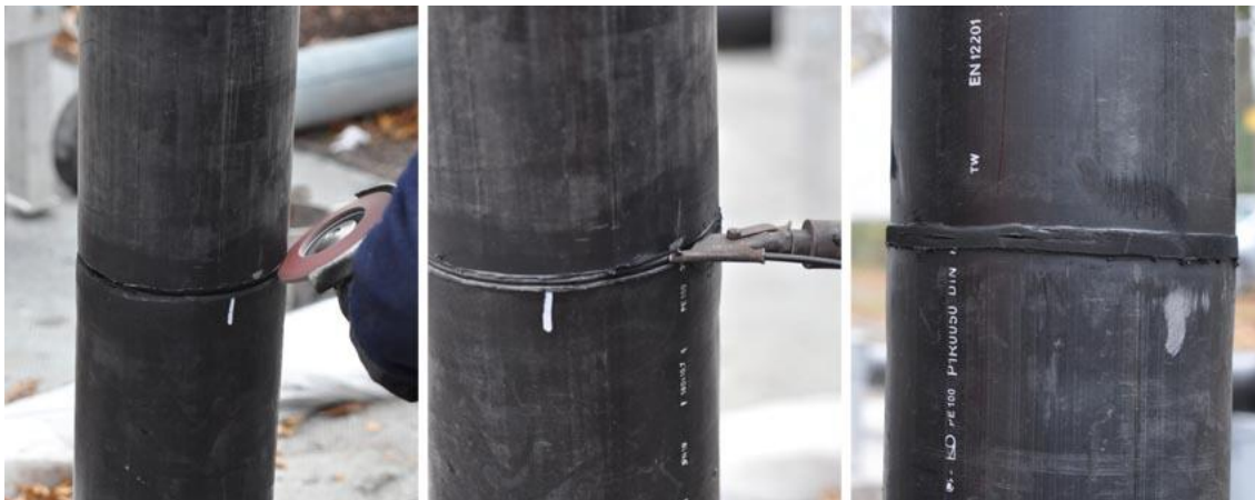
Abbildung 5-4: Warmgasschweißen der PE-Innenrohre beim Einbau der PE-Innenrohre
