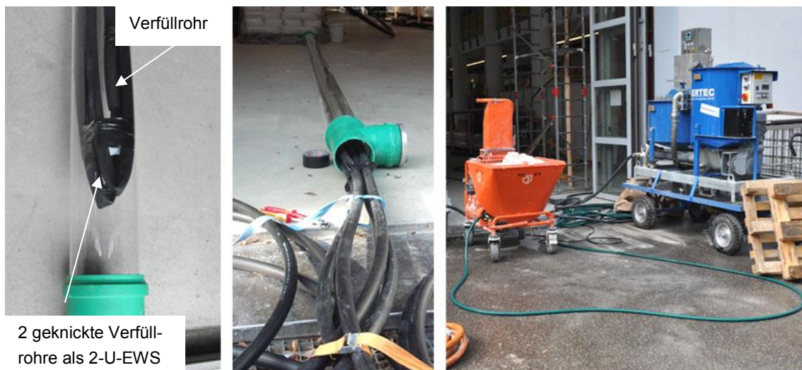
Abbildung 4-5: Einbau der Sondenrohre in das PMMA-Rohr (links und Mitte) und Ansicht der beiden, bei den Technikumsversuchen verwendeten Misch- und Verfüllanlagen (links: Durchlaufmischer, rechts: Kolloidmischer)
