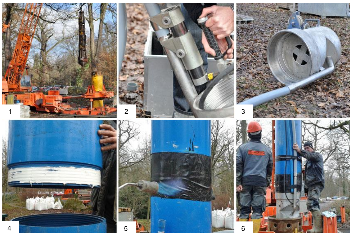
Abbildung 5-1: Ablauf der Arbeiten für die Erstellung der Realmaßstabsversuchsbohrungen. 1: Bohrarbeiten im Greiferbohrverfahren; 2: Anbringung der Edelstahlschiebehülse an der Verbindung Umwälzrohr-Edelstahlfuß; 3: Fertiggestellter Edelstahlfuß mit angebrachtem Umwälzrohr; 4: Abdichtung der TNA-Gewindeverbindungen (Trapezgewinde nicht auftragend) durch das Auftragen einer Dichtmasse im Außengewinde und (5) Anbringung eines Schumpfschlauchs als mechanischer Schutz; 6: Einbau des PVC-Außenrohrs inklusive Umwälzrohr, Glasfaserkabel und Pegelrohr zur Messung des Grundwasserstands
