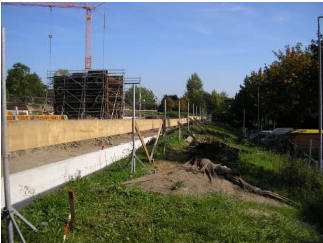
Abb. 24 Leuze-Bad / Parkhaus-Neubau: Blick von Baustelle zur umliegenden Wohnbebauung (oben) und Blick auf den Erdwall zwischen Baustelle und Wohnbebauung (unten). Abschirmungen auf dem Erdwall sind möglich und sollten in gesamter Erdwall-Länge ausgeführt werden.
