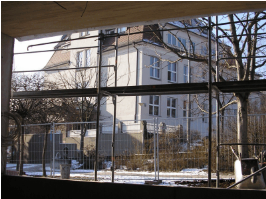
Abb. 22 Pragschule / Kindertagesstätte Neubau: Blick von der Schule zur Baustelle (oben) und Blick von der Baustelle zur Schule (unten). Abschirmungen im Bereich des Bauzaunes sind problemlos möglich.
