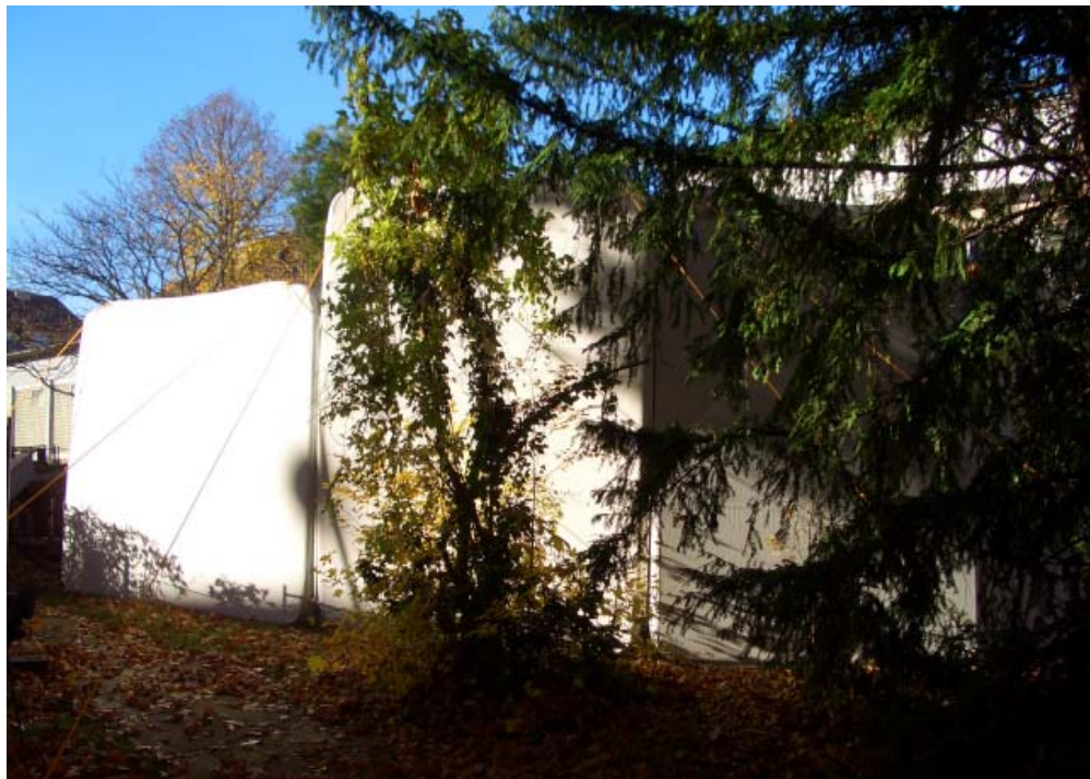
Abb. 32 Friedrich-Eugens-Gymnasium / Mensa-Anbau: Bilder vom Baustelleneinsatz aufblasbarer Abschirmungen. Lärmschutz der anliegenden Wohnbebauung vor Sägearbeiten mit einer Tischkreissäge (oben) und Ansicht der Abschirmung aus Richtung der Immissionsorte (unten).
