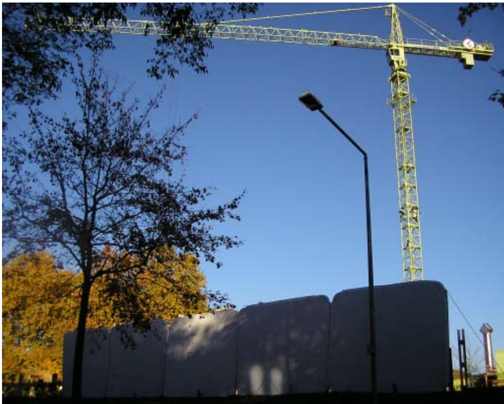
Abb. 31 Leuze-Bad / Parkhaus-Neubau: Bilder vom Baustelleneinsatz aufblasbarer Abschirmungen. Lärmschutz der anliegenden Wohnbebauung vor Profilarbeiten mit einem Kettenbagger (oben) und Ansicht der Abschirmung aus Richtung der Immissionsorte (unten).
