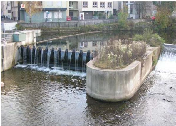
Bild 5: Leerschuss mit Fischbauchklappe
