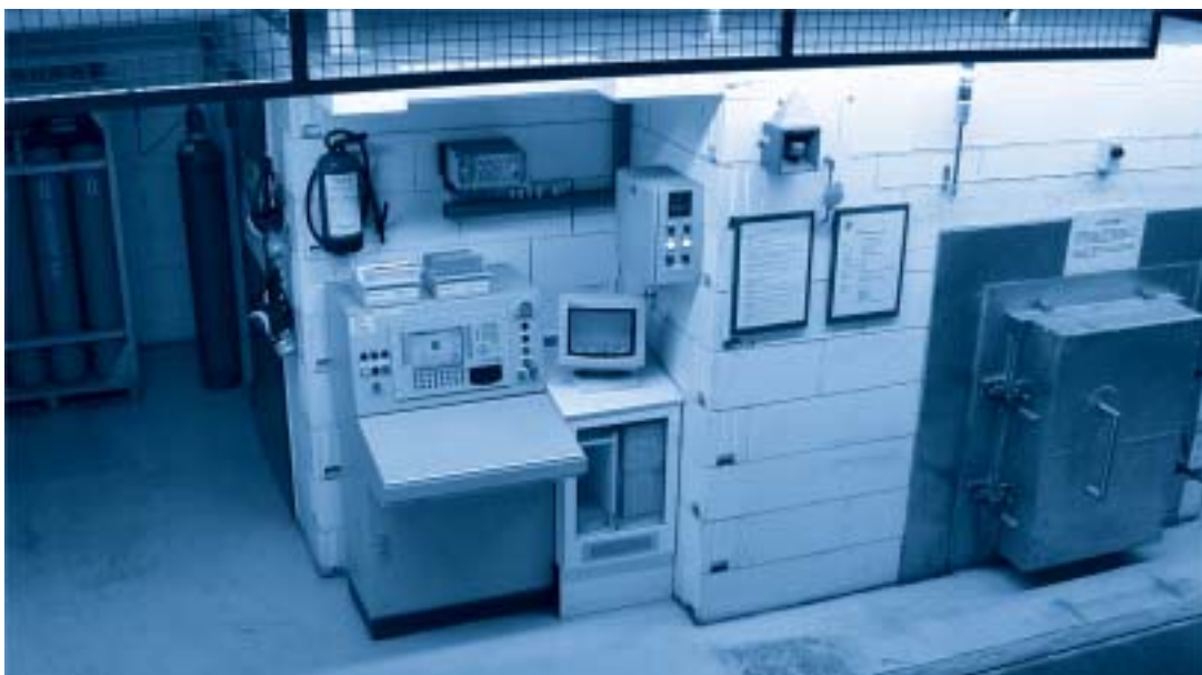
Abb. 4.3: Fluorieranlage der Stoz Oberflächentechnik GmbH & Co. KG [Stoz 2000]
